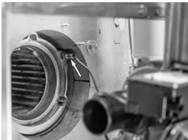
Fig. 30 : insertion de l'eSTB
