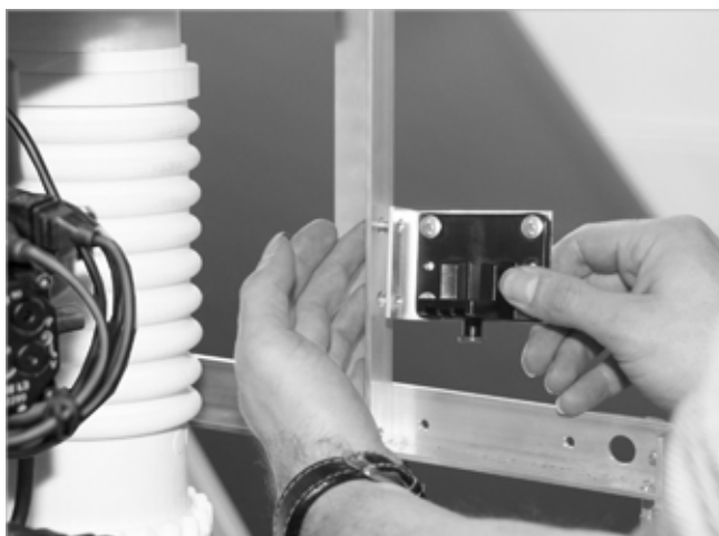
Fig. 66 : fixation du support du filtre à fioul
