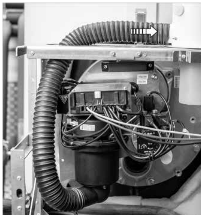
Fig. 59 : montage du tuyau d'amenée d'air
