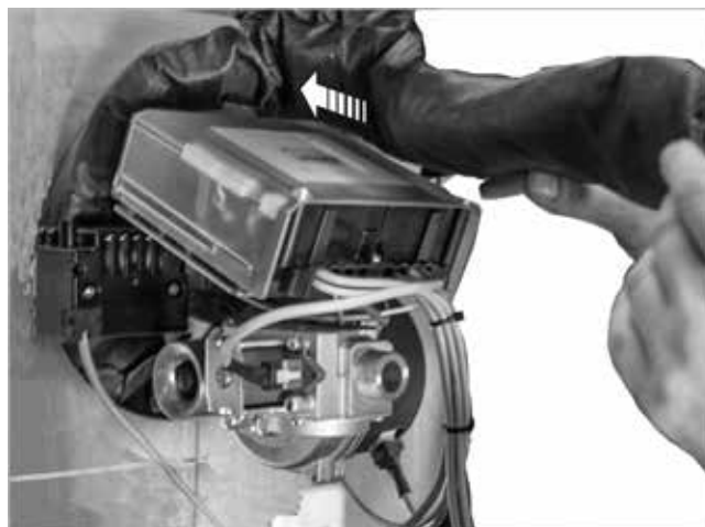
Fig. 32 : remplir la cavité au niveau de la bride du brûleur
