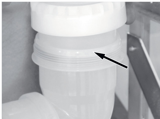
Afb. 43: De rookgasbocht recht uitgelijnd vastschroeven
