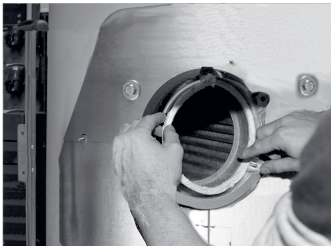
Afb. 30: Branderpakingsnoer plaatsen, kopse kanten boven
