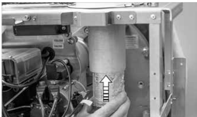
Afb. 62: Inwendige geluiddemper plaatsen
