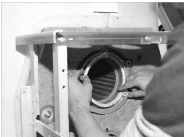
Afb. 53: Branderpakingsnoer plaatsen, kopse kanten boven
