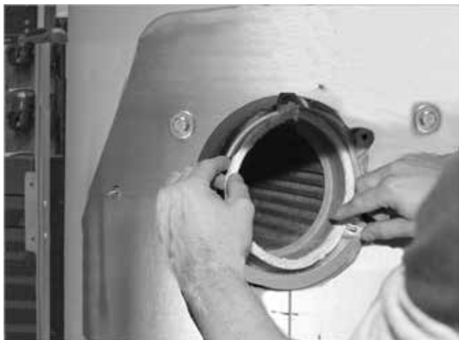
Afb. 30: Branderpakingsnoer plaatsen, kopse kanten boven
