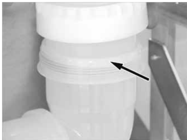
Afb. 43: De rookgasbocht recht uitgelijnd vastschroeven
