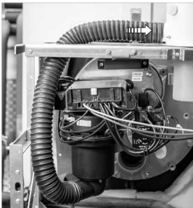
Afb. 60: Toevoerluchtslang monteren
