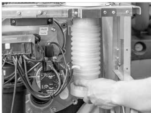
Afb. 64: Rookgasaansluitleidingstuk recht uitlijnen
