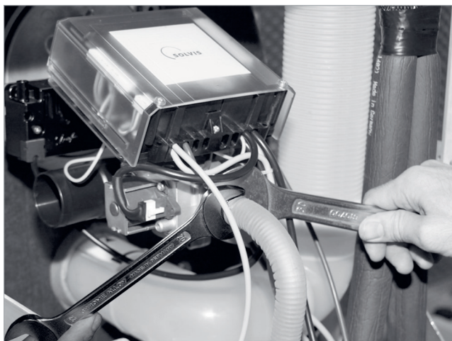
Fig. 60: collegamento della condotta del gas
