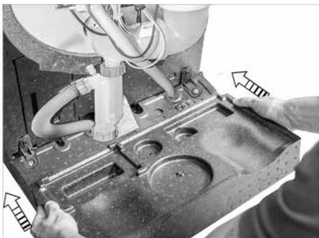
Fig. 93: Innestare la parte anteriore della base
