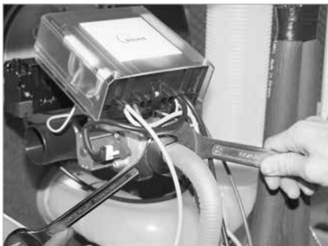
Fig. 60: collegamento della condotta del gas
