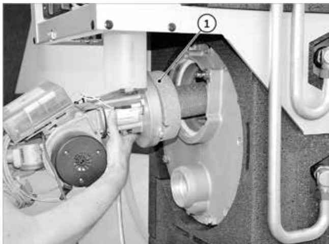
Fig. 49: Montaggio del bruciatore
