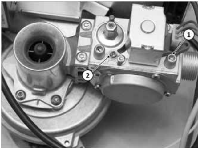
Fig. 113: impostazione del bruciatore
