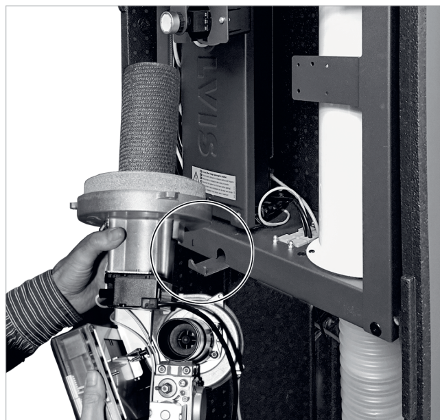
Fig. 136: Enganche del quemador en la consola (posición de mantenimiento)
