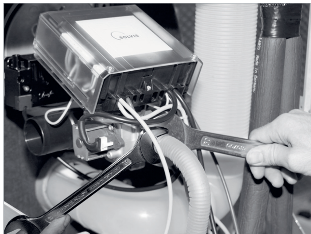
Fig. 60: Conectar la tubería de gas
