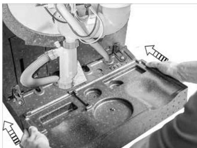
Fig. 93: Insertar pieza inferior delantera
