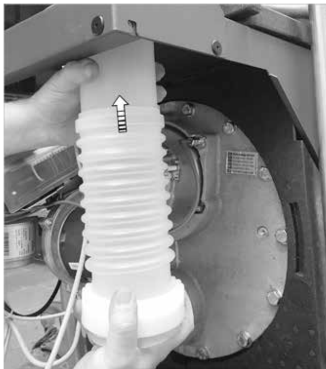
Fig. 84: Enchufe la pieza de conexión para la salida de humos en el tubo de salida de humos.
