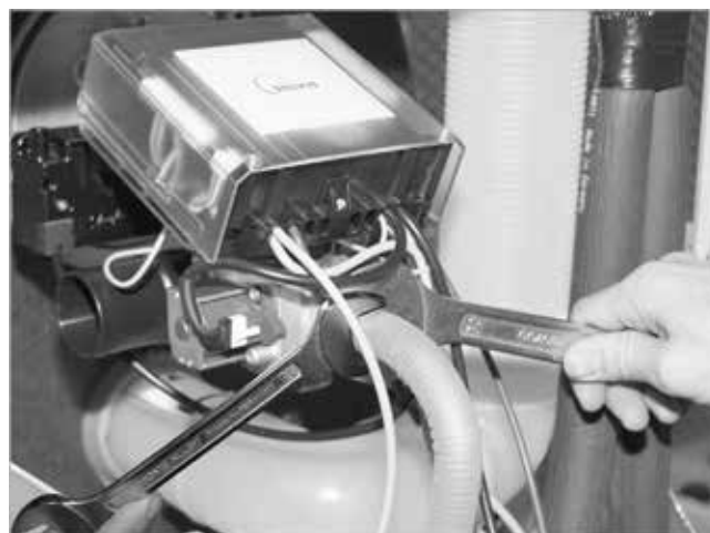
Fig. 60: Conectar la tubería de gas
