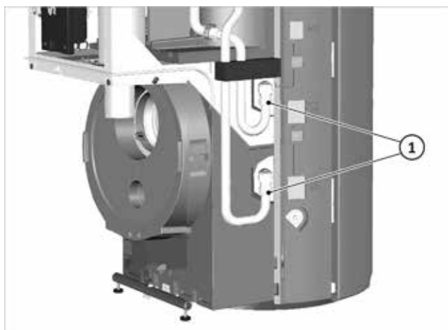
Fig. 31: Control/reapriete de las conexiones de la estación de circuito de calefacción
