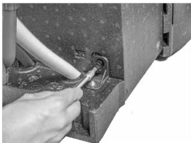
Fig. 92 : fixation de l'équerre
