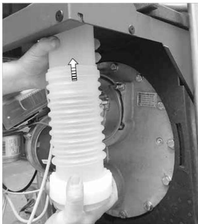
Fig.84 : enfichage du raccord d'évacuation des gaz sur la conduite d'évacuation des gaz.
