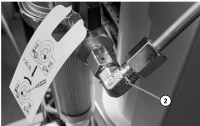
Fig. 78 : raccordement de la conduite d'alimentation en fioul au filtre
