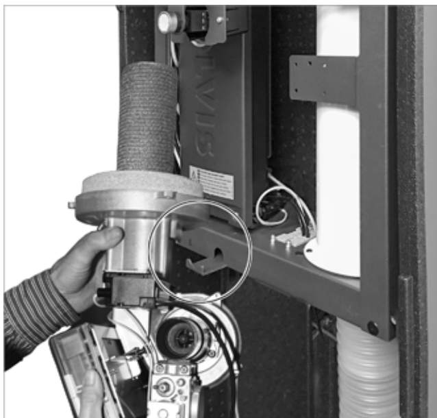
Fig. 134 : accrochez le brûleur sur la console (position de maintenance)
