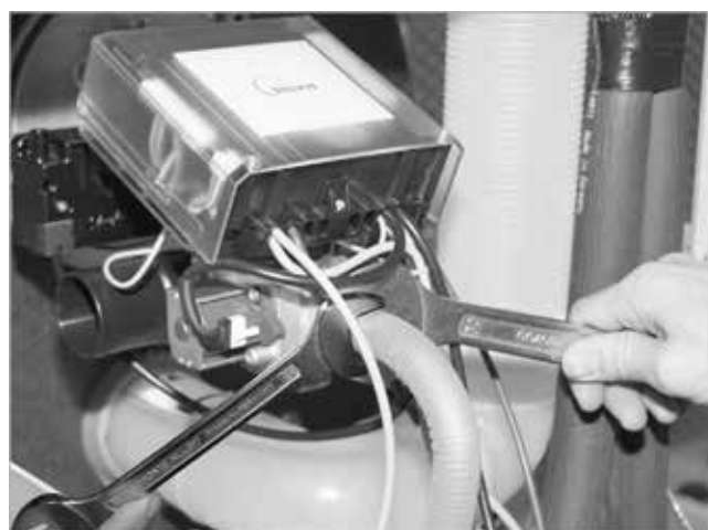
Fig. 60 : Raccordement de la conduite de gaz
