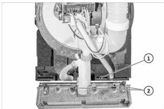
Fig. 90 : passage des câbles par le fond
