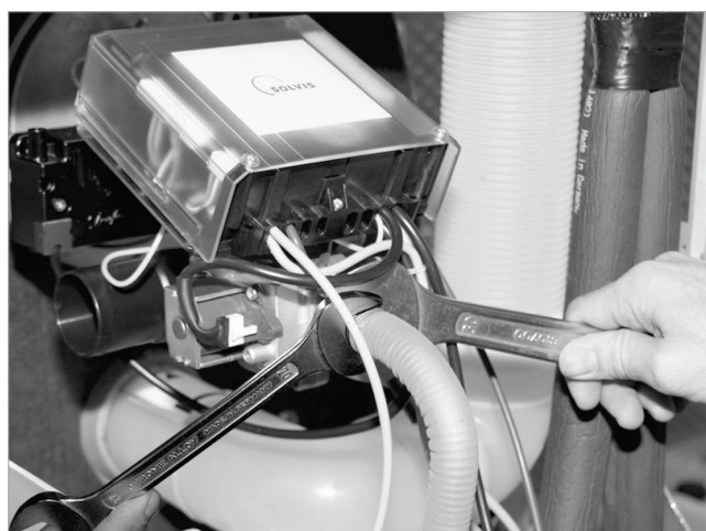
Fig. 60 : Raccordement de la conduite de gaz
