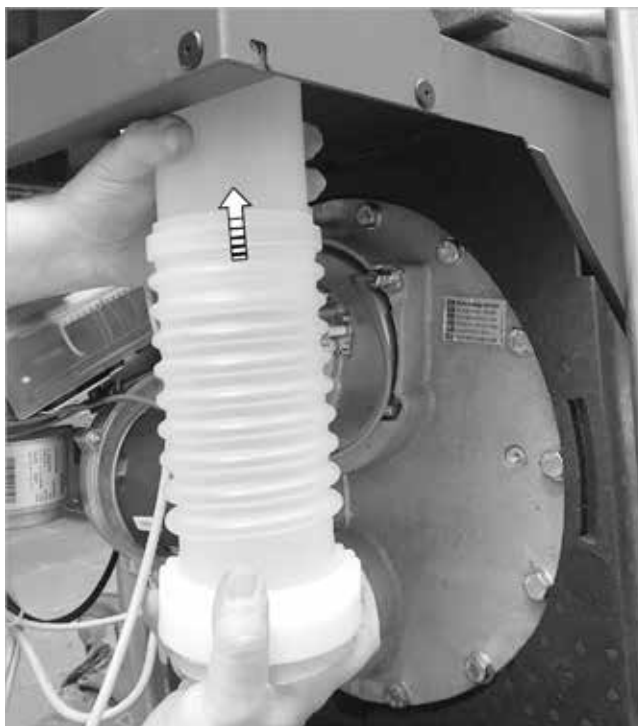
Afb.84: Het aansluitstuk voor rookgas op de rookgaspijp steken.
