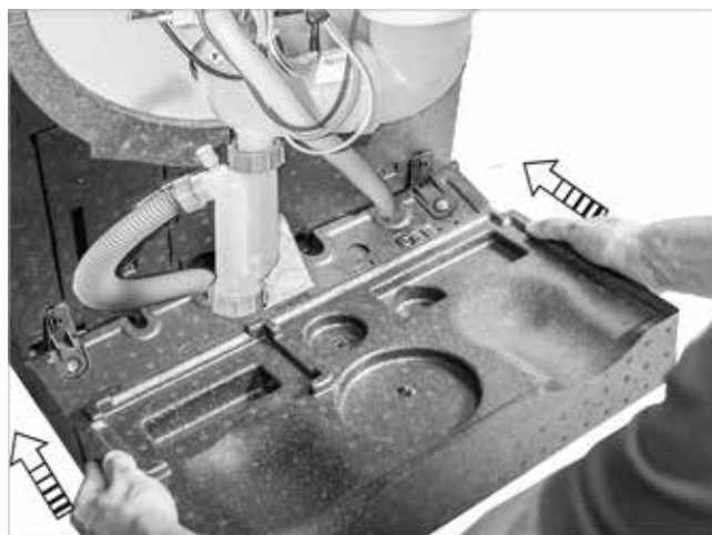
Afb. 93: Voorste vloerdeel monteren
