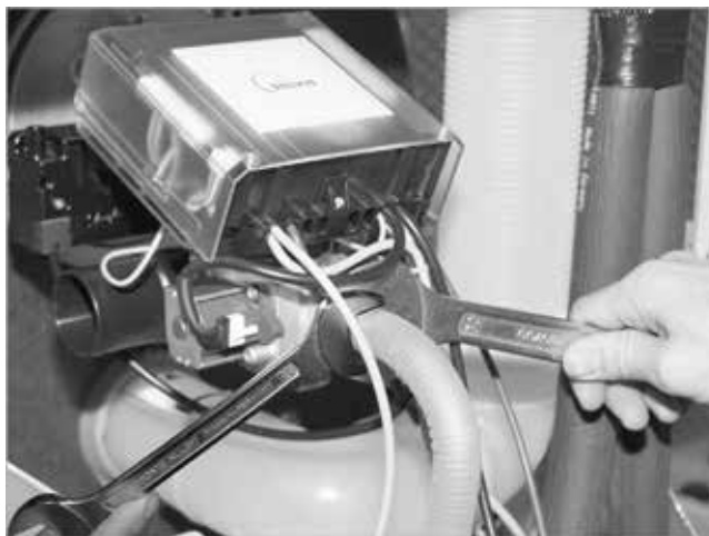
Afb. 60: Gasleiding aansluiten
