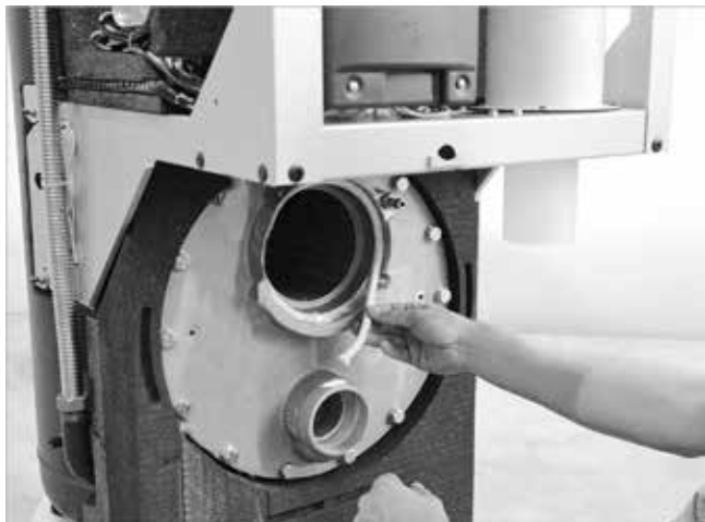
Afb. 64: Branderpakkingsnoer aanbrengen
