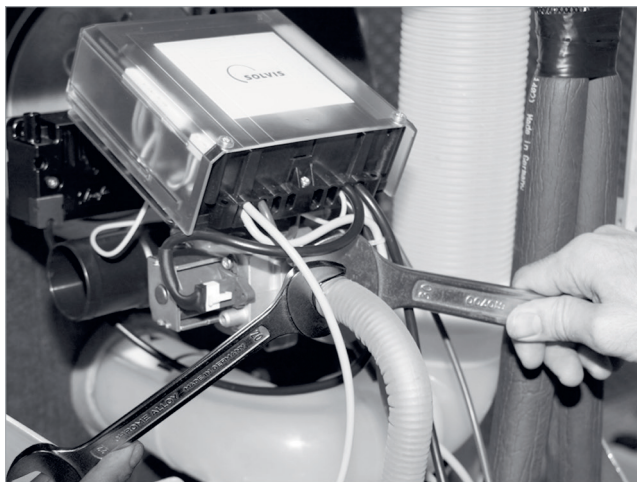
Afb. 60: Gasleiding aansluiten
