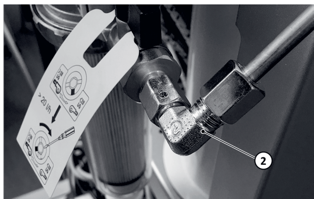
Afb. 78: Olietoevoerleiding op filter aansluiten
