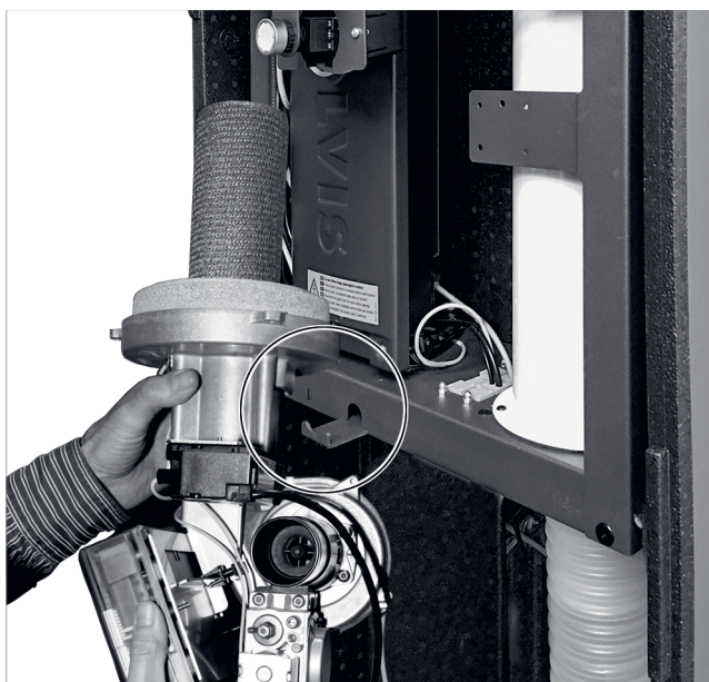
Afb. 136: Brander aan de console hangen (onderhoudspositie)
