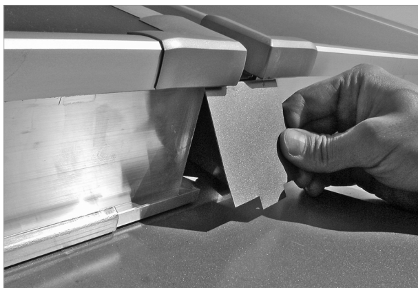
Abb. 89: Die kleinen Bleche vor die Zwischenräume der Kollektoren setzen
