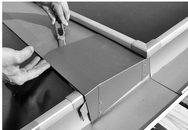
Abb. 77: Bei nachträglichem Zugang: Klebeverbindung zwischen den Blechen lösen ...
