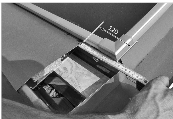
Abb. 71: Blech auf Abstand zur Außenkante bringen
