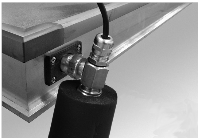
Abb. 92: Sensor montieren (Solar-Vorlauf)
