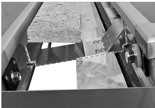
Abb. 62: Sitz der Kollektordistanzstücke an den Kollektoren
