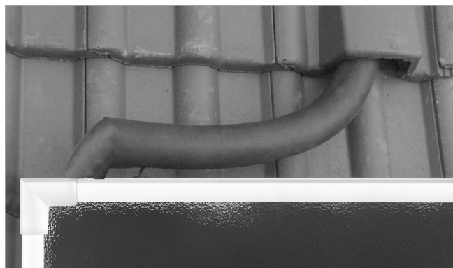
Abb. 93: Rücklauf anschließen
