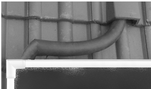
Fig. 93: Collegamento del ritorno
