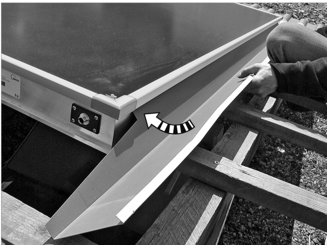
Fig. 56: posizionamento della lamiera nella scanalatura sotto il profilato a clip, montaggio successivo sul collettore
