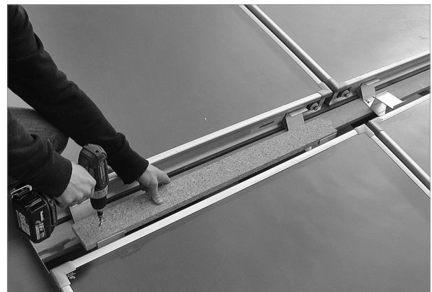
Fig. 68: avvvitamento dei sostegni per le lamiere intermedie sui distanziali dei collettori
