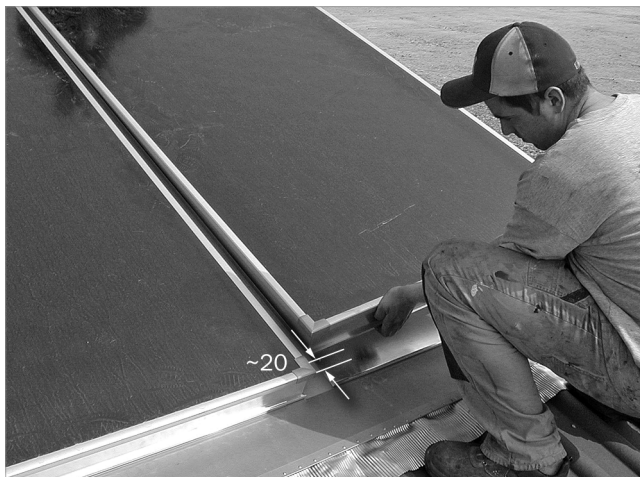
Fig. 54: applicare il prossimo collettore e spingerlo verso il basso contro la lamiera di supporto.
