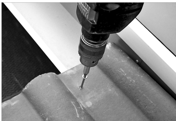
Fig. 88: fissare le tegole accanto alla lamiera laterale
