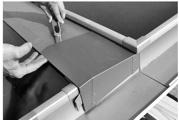
Fig. 77: per il successivo accesso: rimuovere il giunto incollato dal nastro isolante di giunzione...
