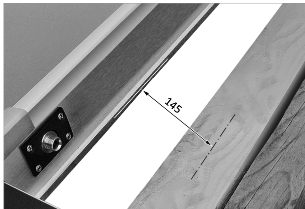
Fig. 60: per la fila successiva di collettori, montare all'occorrenza un ulteriore tavolato al di sopra del collettore.
