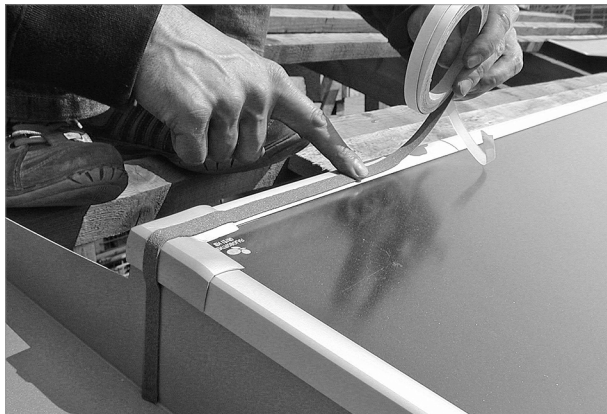
Fig. 69: incollare il nastro isolante di giunzione nel bordo superiore su tutta la larghezza
