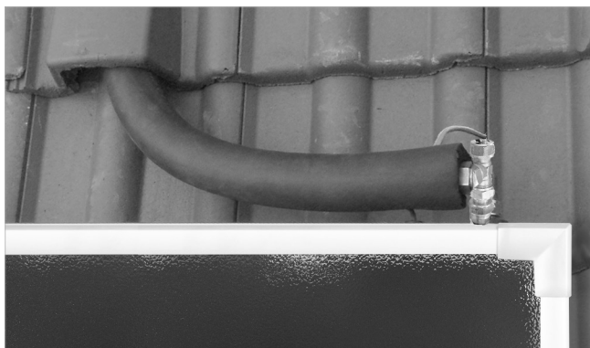
Fig. 94: Collegamento della mandata
