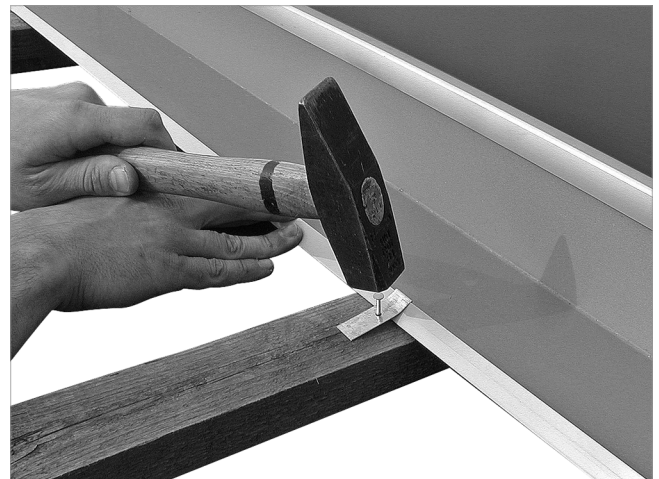
Fig. 59: fissaggio della lamiera ai correntini del tetto con chiodi e linguette
