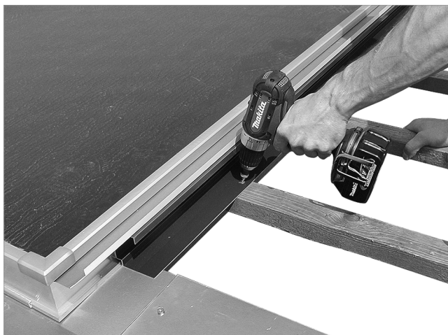
Fig. 53: spingerla verso il basso contro la battuta e avvitare con i correntini del tetto
