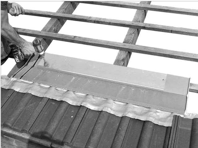
Fig. 47: montaggio e serraggio a destra della prima lamiera
