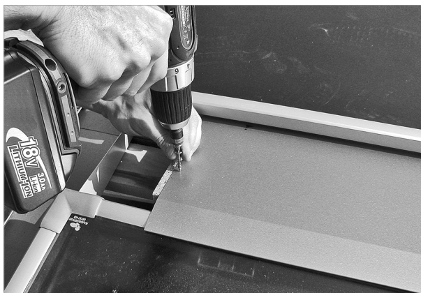
Fig. 72: avvitamento della lamiera intermedia a circa 10 mm dal bordo esterno sinistro
