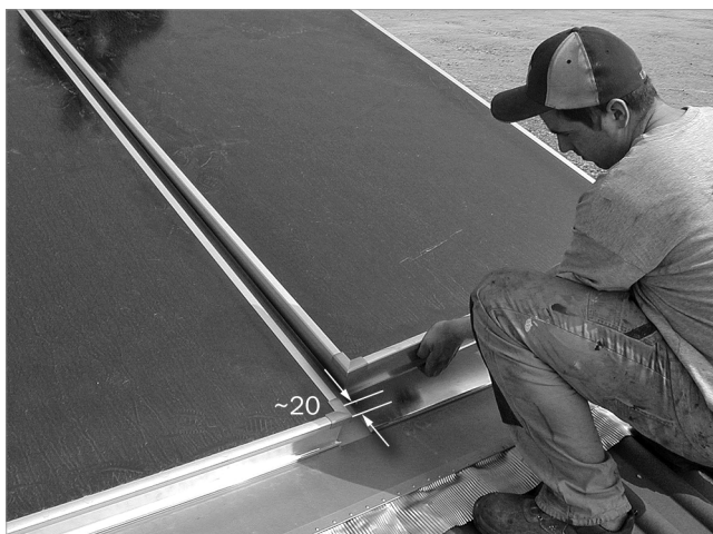
Fig. 54: Colocar el colector siguiente y empujar hacia abajo contra la chapa de sujeción
