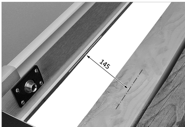
Fig. 60: Colocar un tablón adicional para otra hilera de colectores por encima del colector
