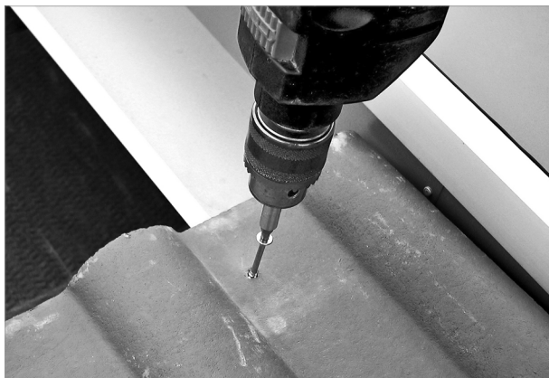
Fig. 88: Fijar la teja junto a la chapa lateral
