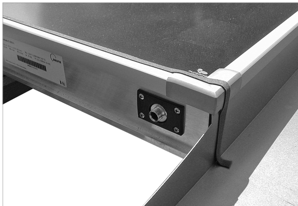
Fig. 79: Pegar la banda de estanqueidad al borde superior en toda su anchura
