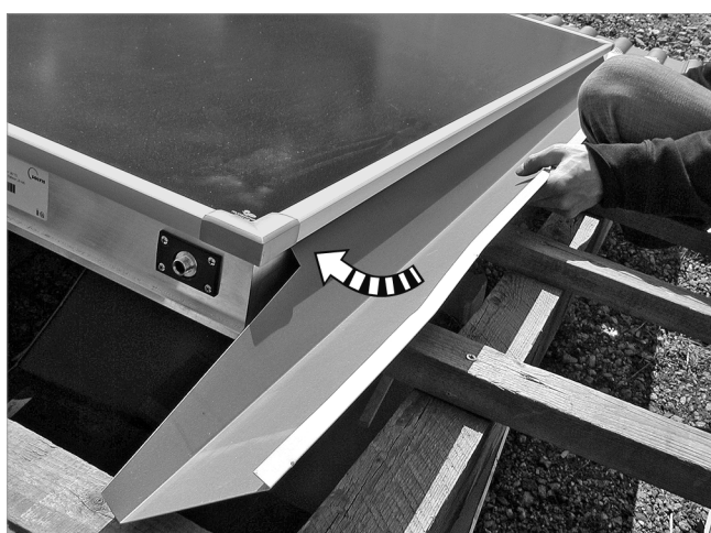
Fig. 56: Colocar la chapa en la ranura bajo el perfil de clip y después en el colector
