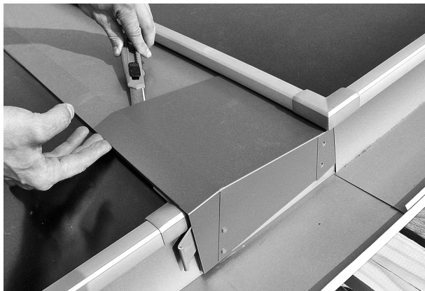
Fig. 77: En caso de acceso posterior: soltar la unión adhesiva entre las chapas ...
