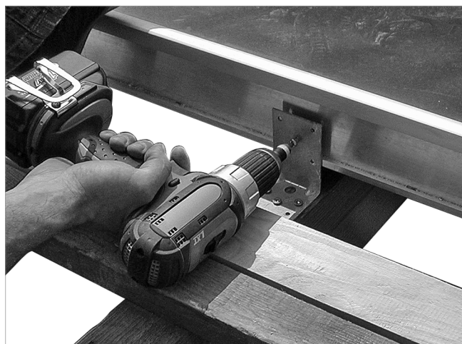
Fig. 51: Fijar al lado frontal superior del colector en una ripia
