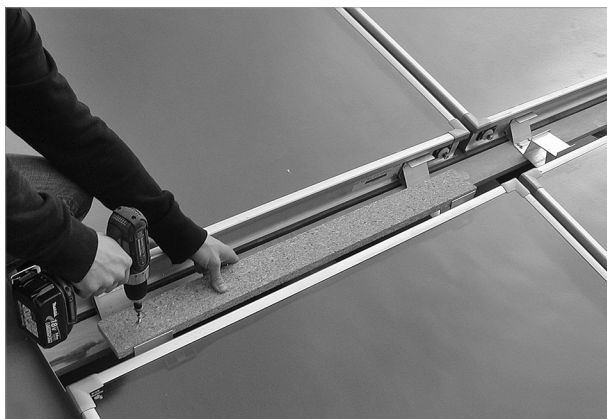
Fig. 68: Atornillar los apoyos de la chapa intermedia a los distanciadores de colectores
