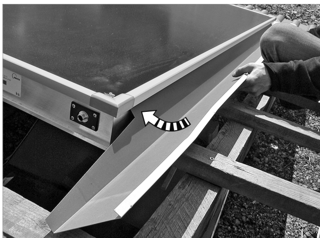
Fig. 64: Colocar la chapa en la ranura bajo el perfil de clip y después en el colector
