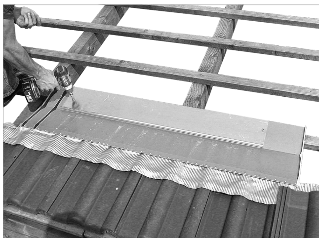
Fig. 47: Colocar la primera chapa por la derecha y atornillarla
