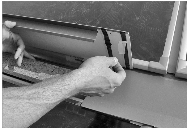
Fig. 75: Montar más chapas: retirar las bandas protectoras antes de la colocación
