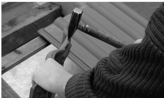
Fig. 87: Retirar las lengüetas de sujeción de ser necesario
