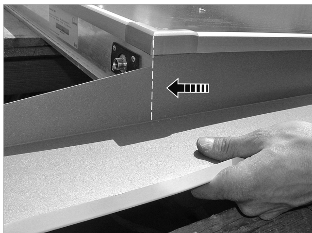
Fig. 57: Empujar la chapa lateral superior hacia arriba contra el tope
