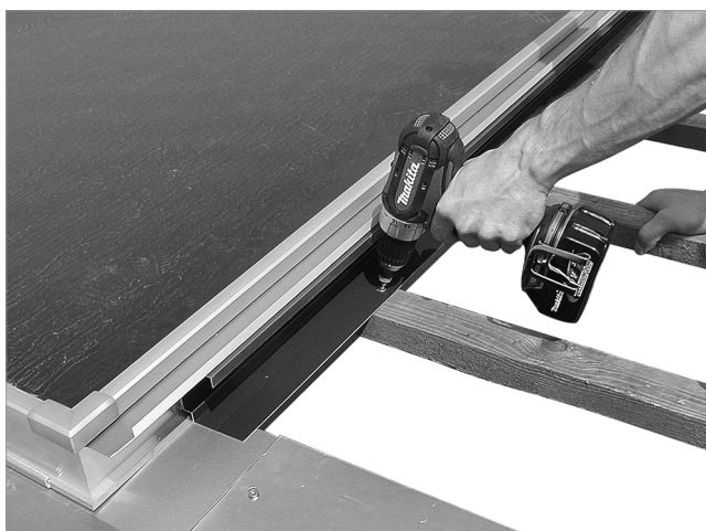
Fig. 53: Empujar hasta el tope hacia abajo y atornillar con las ripias
