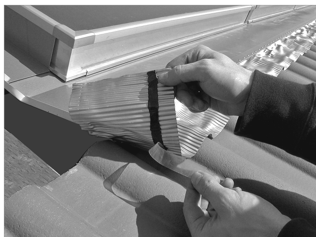
Fig. 49: Retirar las bandas protectoras y presionar las chapas de plomo
