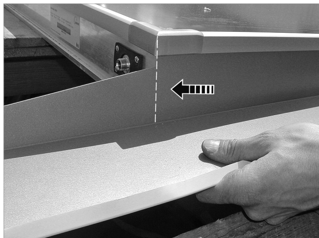
Fig. 65: Empujar la chapa lateral superior hacia arriba contra el tope
