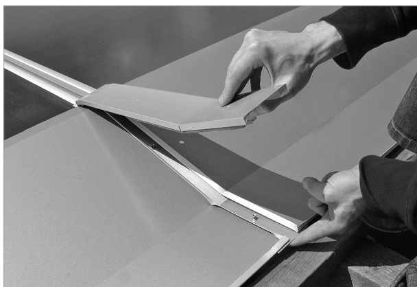
Fig. 82: Cubrir la chapa superior del conector con la chapa inferior
