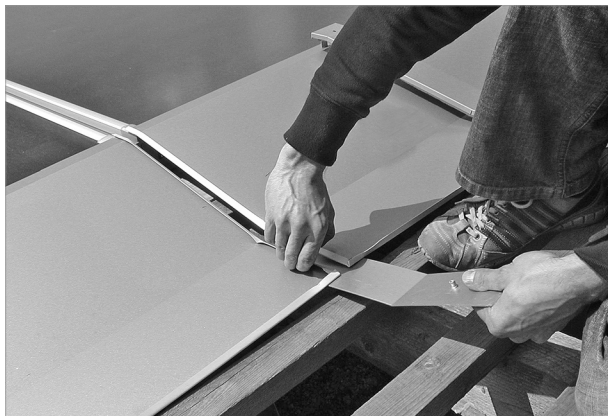
Fig. 81: Empujar la chapa inferior del conector de forma que se ajuste bajo la chapa superior
