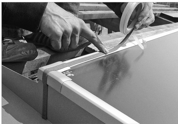
Fig. 69: Pegar la banda de estanqueidad al borde superior en toda su anchura
