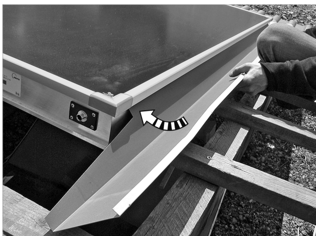
Afb. 56: De plaat op de sleuf onder het onderste klemprofiel plaatsen en dan tegen de collector aan schuiven
