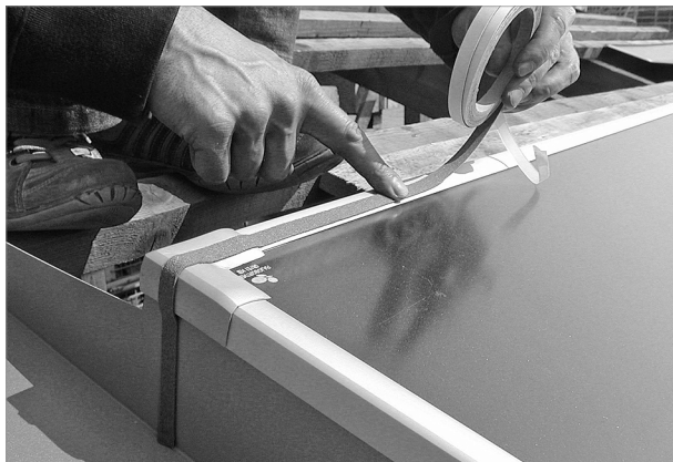
Afb. 69: Voegenafdichtband over de gehele breedte van de bovenste rand plakken
