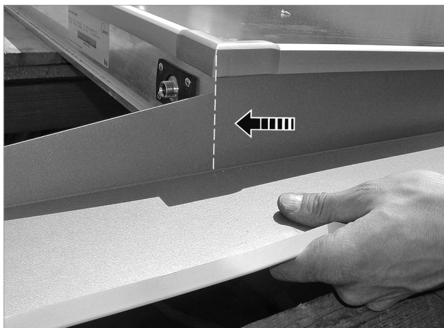
Afb. 57: Het bovenste gedeelte van de zijplaat naar boven toe tegen de aanslag aan schuiven
