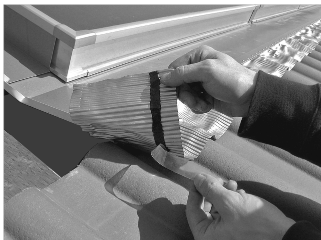
Afb. 49: Beschermingsfolie wegtrekken en loodslabben aandrukken.
