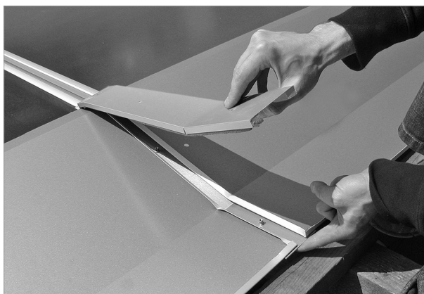
Afb. 82: De bovenste plaat van de koppeling met de onderste in lijn brengen
