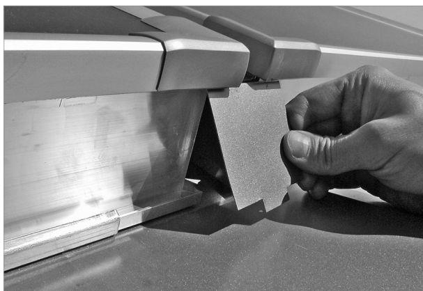
Afb. 89: De kleine afdekplaatjes voor de tussenruimtes van de collectoren plaatsen
