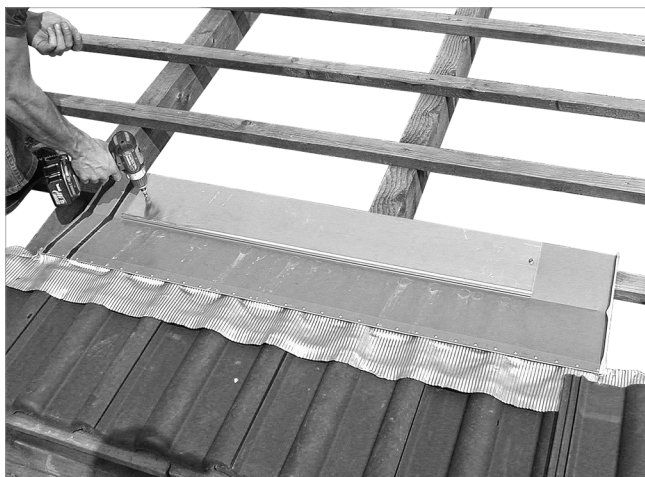
Afb. 47: Aan de rechter zijde de eerste plaat plaatsen en vastschroeven.
