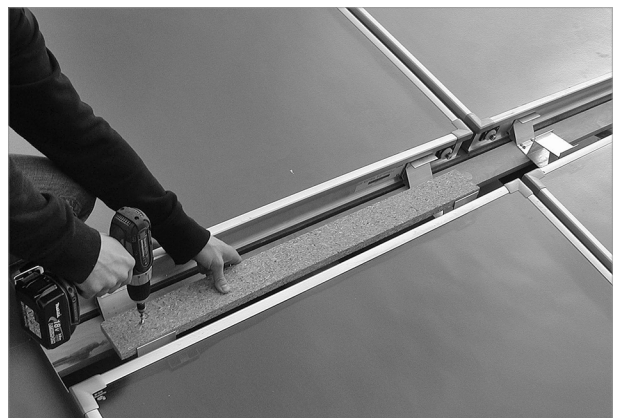
Afb. 68: De tussenplaatsteunen op de collector-afstandsstukken schroeven
