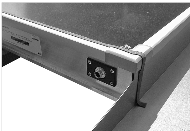
Afb. 79: Over de gehele breedte op de bovenste rand voegenafdichtband plakken
