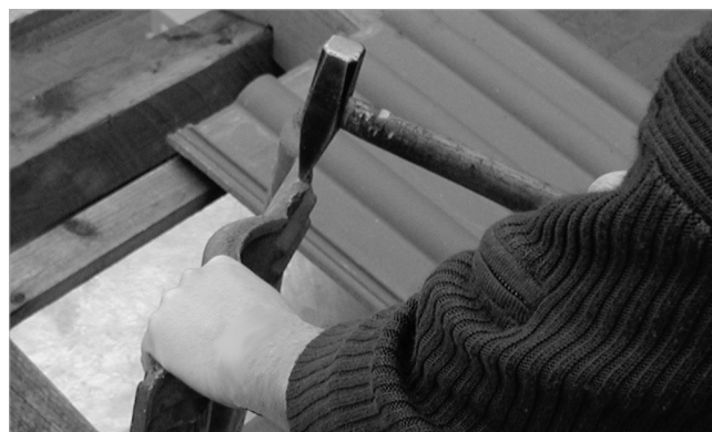
Afb. 87: Evt. de neuzen (nokken) verwijderen
