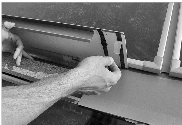
Afb. 75: Overige platen monteren: Voor het plaatsen beschermfolie wegtrekken
