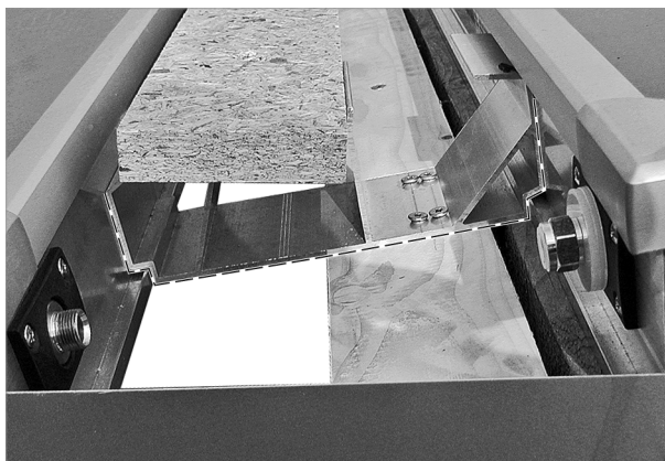
Afb. 62: Positie van de collector-afstandsstukken aan de collectoren
