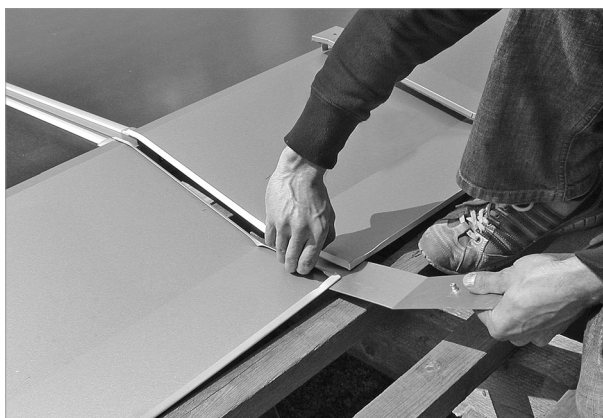
Afb. 81: De onderste plaat van de verbinder onder de bovenplaten schuiven
