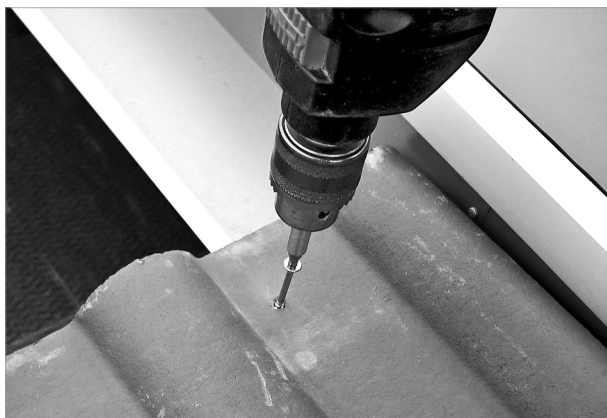
Afb. 88: Dakpan naast de zijplaat bevestigen
