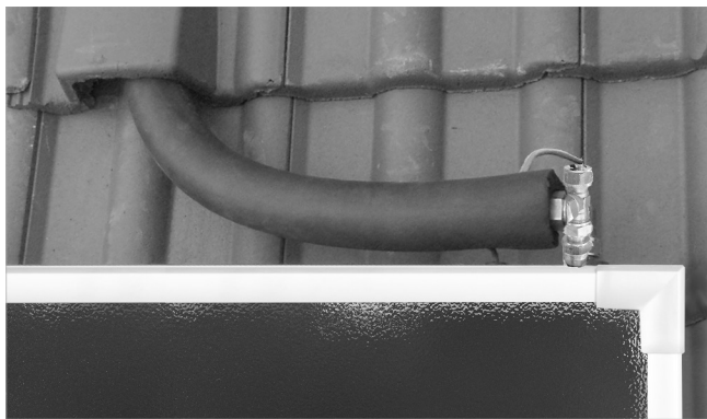
Afb. 94: De aanvoerleiding aansluiten
