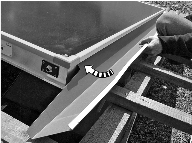
Afb. 64: De plaat op de sleuf onder het onderste klemprofiel plaatsen en dan tegen de collector aan schuiven
