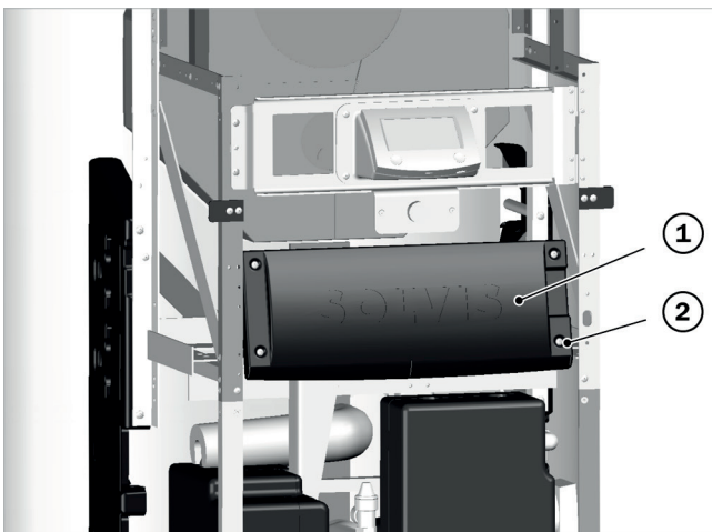
Abb. 21: Deckel der Netzplatine befestigen
