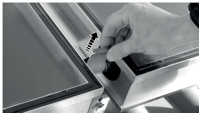
Fig. 17: Retirar manguito distanciador
