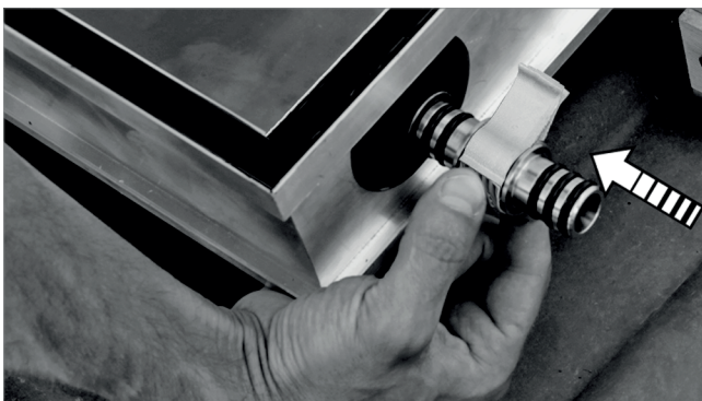
Fig. 32: Insertar un conector de colector
