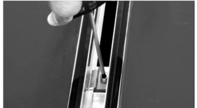
Fig. 34: Apretar pinzas intermedias
