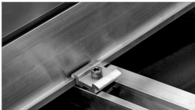
Fig. 13: Pinza intermedia colocada pero sin apretar
