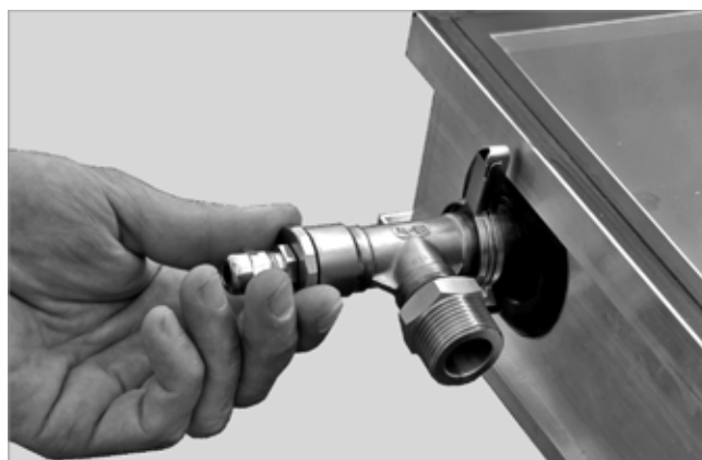
Fig. 39: Conectar el avance solar
