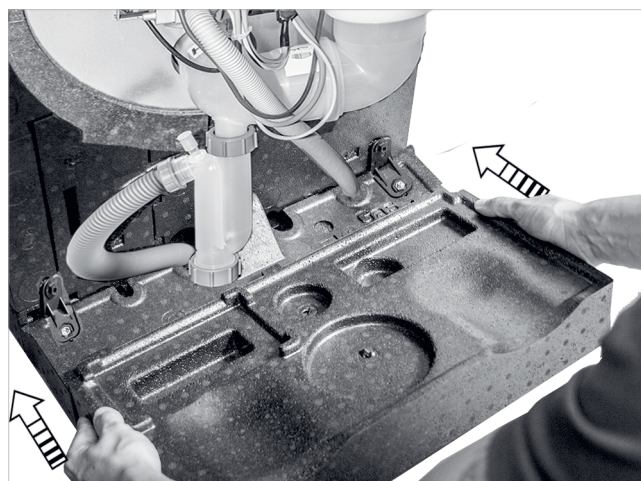
Abb. 93: Vorderes Bodenteil einstecken
