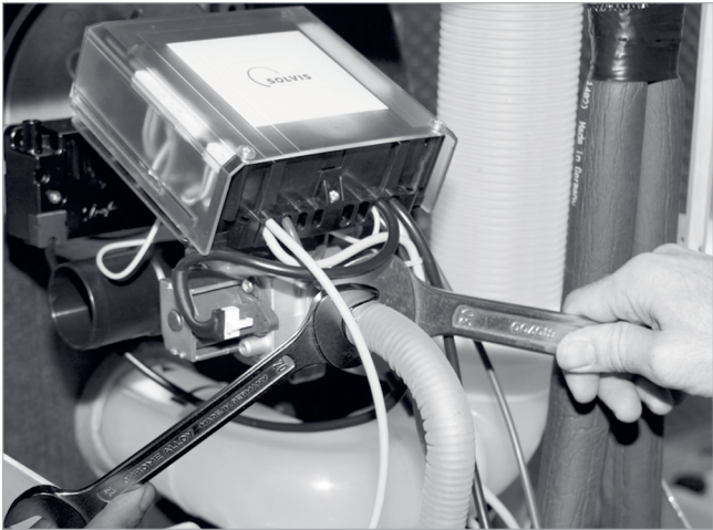
Abb. 60: Gasleitung anschließen
