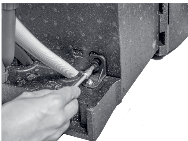
Abb. 92: Winkel befestigen
