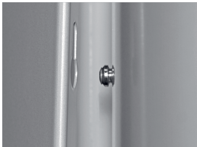
Abb. 43: Bajonettverschluss
