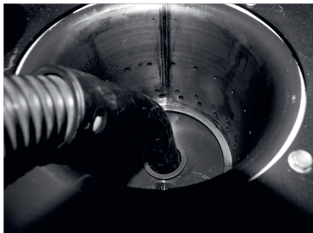
Abb. 154: Primärluftrohr aussaugen
