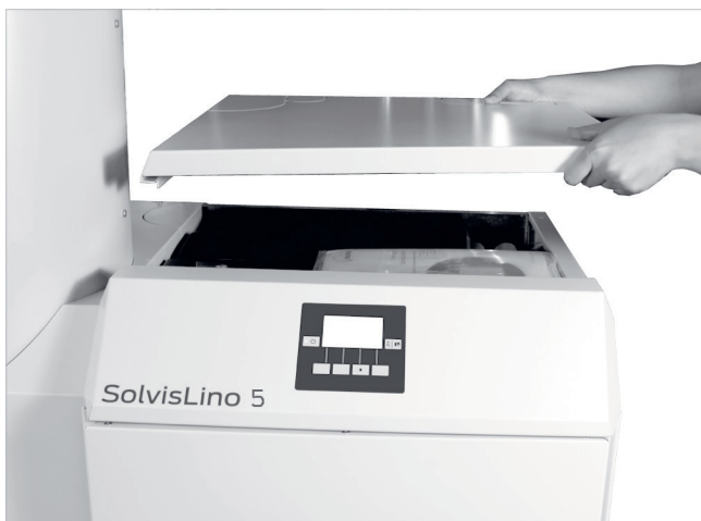
Abb. 157: Verkleidungsdeckel nach hinten abnehmen
