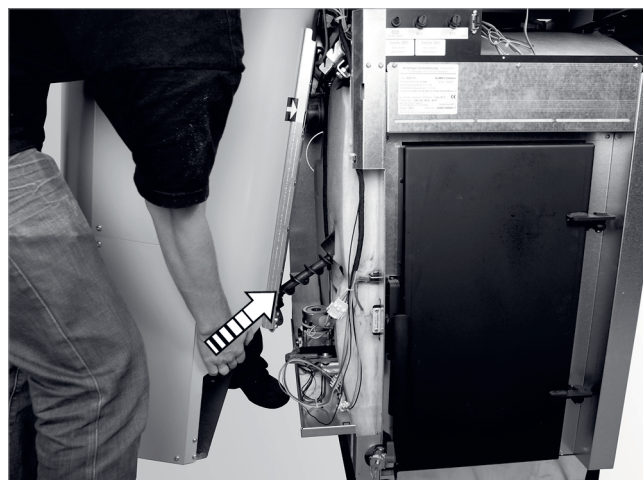
Abb. 28: Förderschnecke einfädeln
