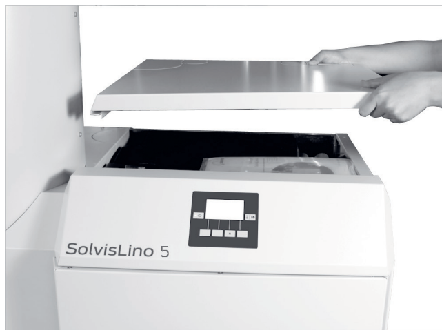
Abb. 108: Verkleidungsdeckel abnehmen
