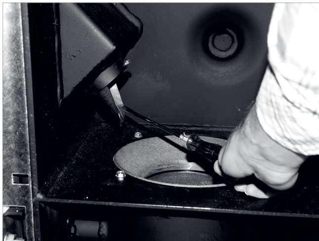
Abb. 144: Fallrinne reinigen
