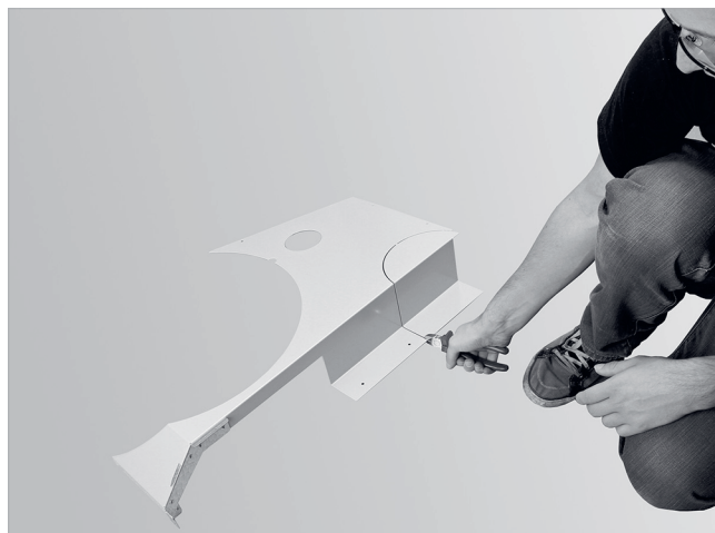
Abb. 75: Nur bei Abgasanschluss nach oben ausbrechen
