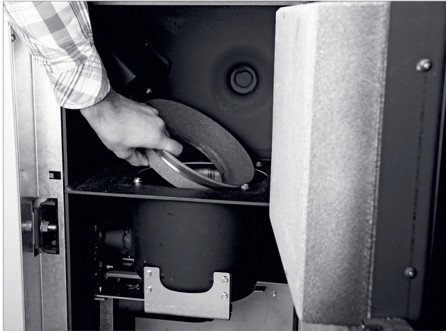
Abb. 146: Konus Oberteil herausheben
