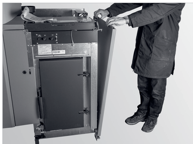
Abb. 87: Seitenwand einhängen
