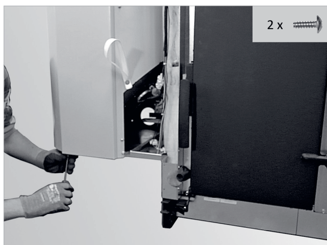
Abb. 174: Schrauben unten entfernen
