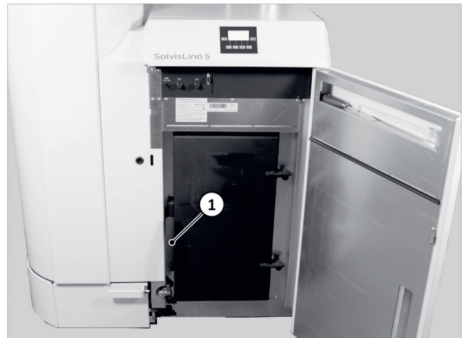
Abb. 128: Hebel (1) nach oben ziehen
