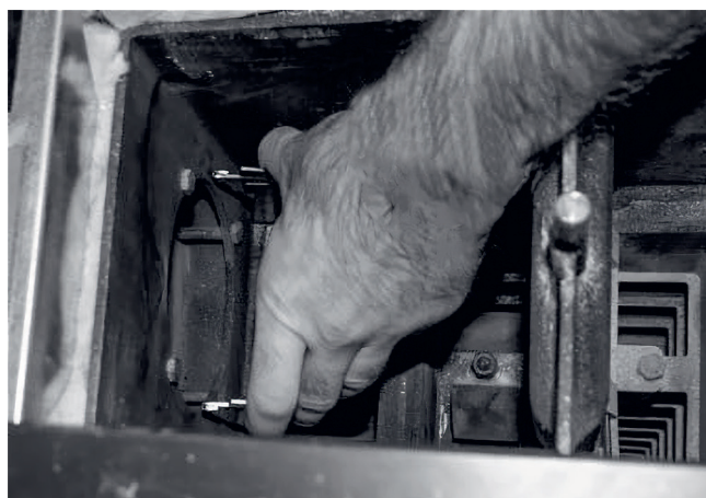
Abb. 163: Umlenblech herausnehmen
