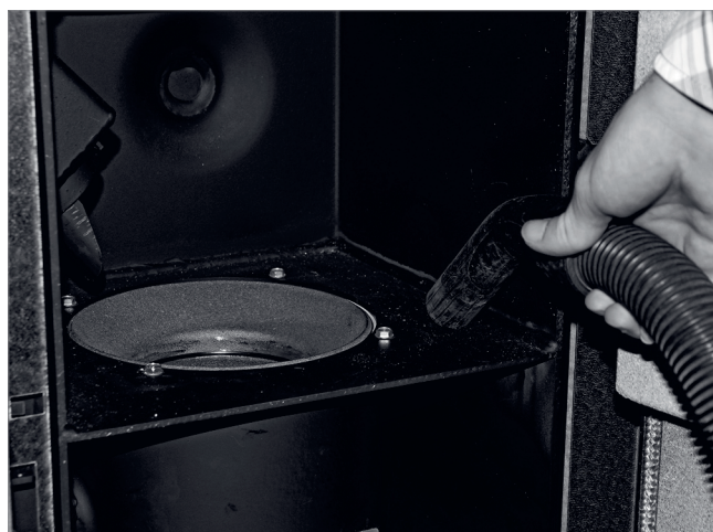
Abb. 145: Verbrennungsrückstände entfernen
