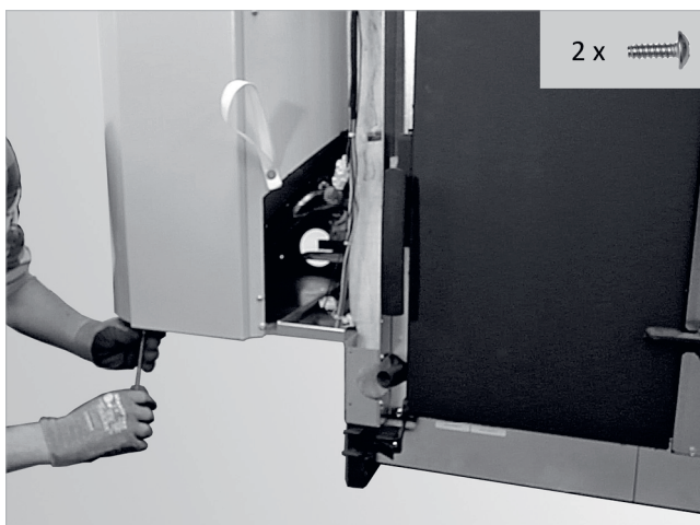
Abb. 39: Blende befestigen
