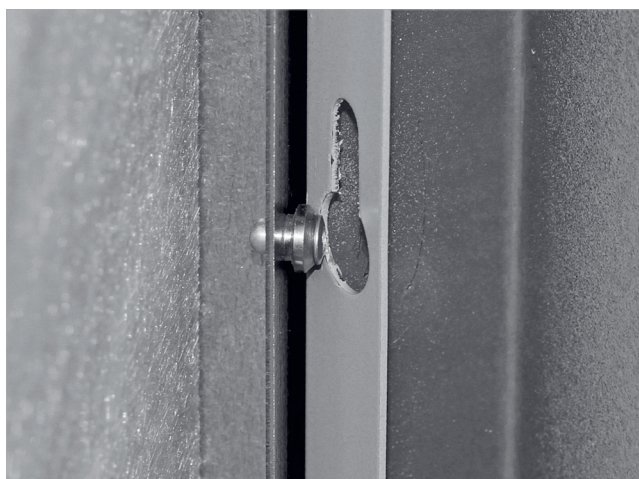
Abb. 86: Bajonettverschluss
