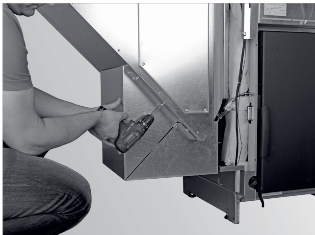
Abb. 60: Sechs Stück Schrauben lockern, Abdeckung abnehmen
