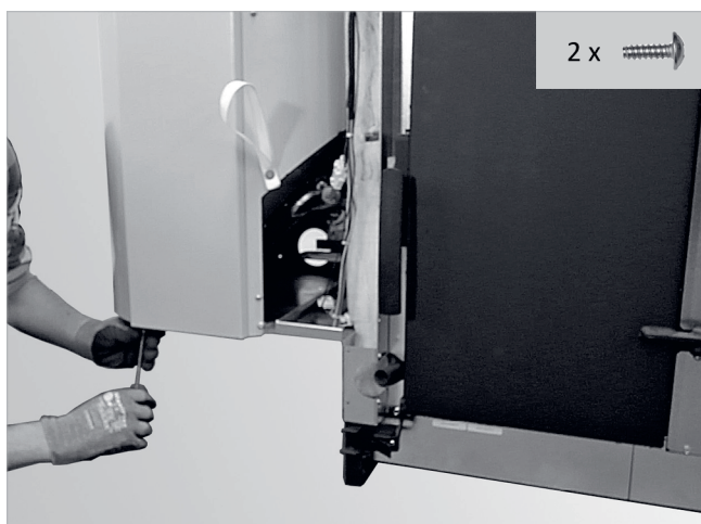
Abb. 32: Zwei Stück Schrauben entfernen
