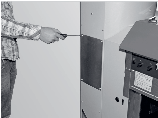
Abb. 176: Revisionsdeckel entfernen
