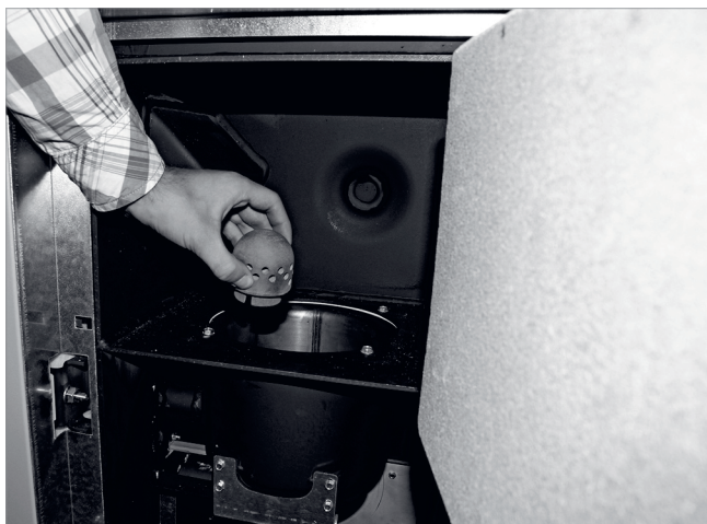
Abb. 151: Primärluftdorn entnehmen
