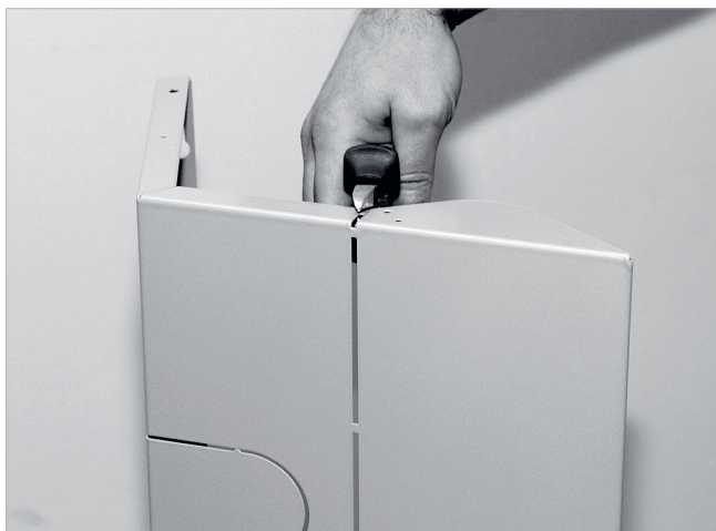
Abb. 70: Steg oben und unten durchtrennen
