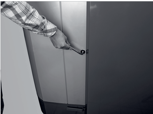
Abb. 127: Mit Sechskantschlüssel Verkleidung öffnen
