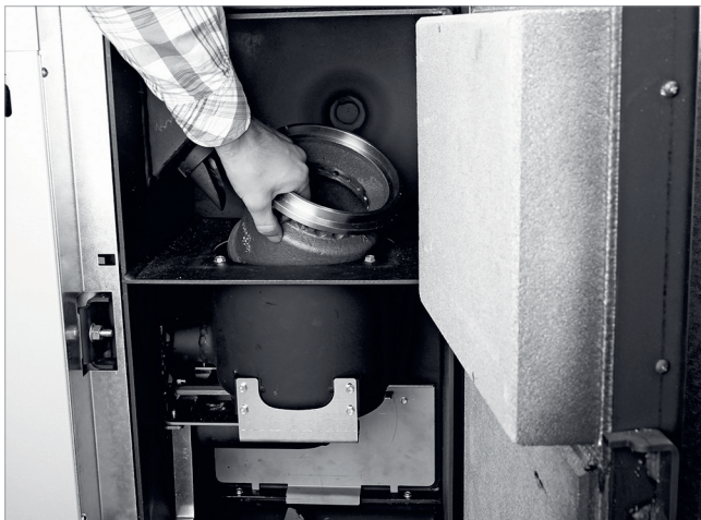
Abb. 147: Konus Unterteil herausheben
