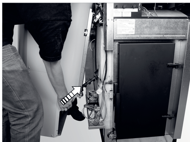
Abb. 56: Schneckenrohr einfädeln
