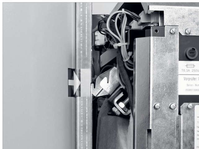
Abb. 29: Vorratsbehälter in beide Haken einhängen
