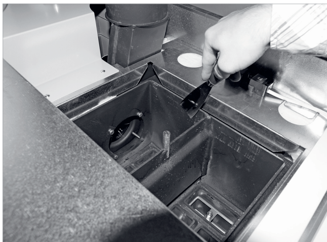
Abb. 166: Nachheizflächen reinigen
