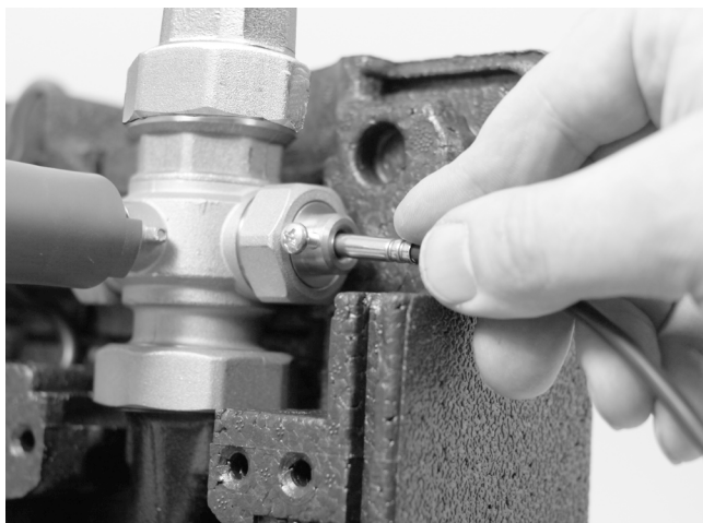
Abb. 15: Vorlaufrühler montieren
