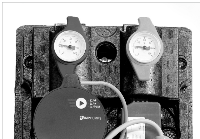
Abb. 4: Kugelhähne rot und blau geöffnet (senkrecht)
