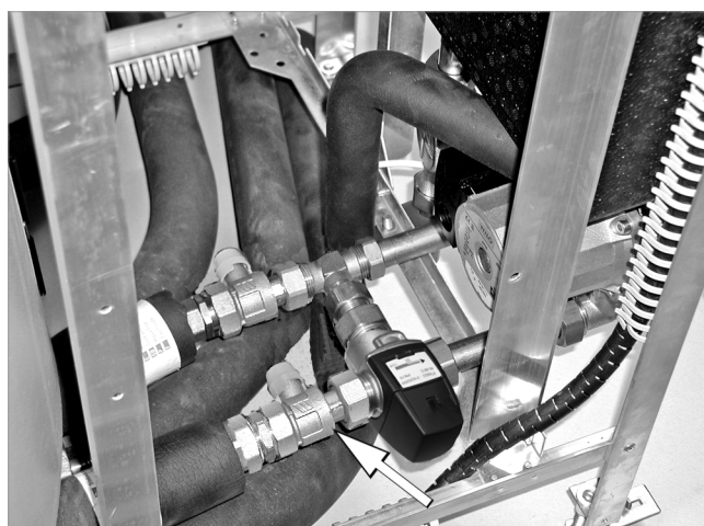
Abb. 3: Anschlussposition am Warmwasservorlauf des SolvisMax 6
