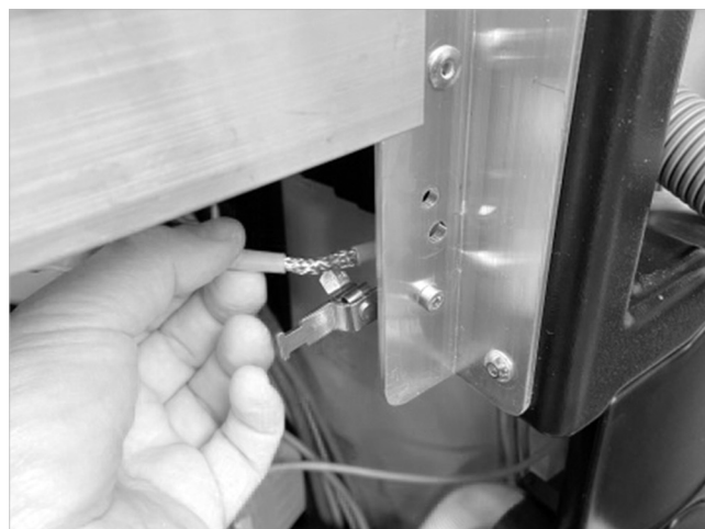
Abb. 11: Schirmklemme am Gestell des Lademoduls von SolvisMax
