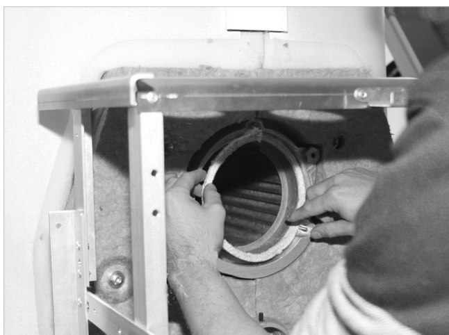
Abb. 20: Brennerdichtschnur einlegen, Stoß oben
