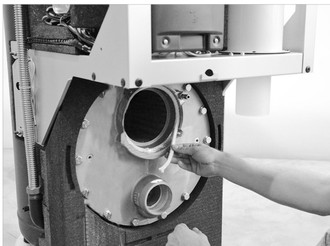
Abb. 1: Brennerdichtschnur einlegen
