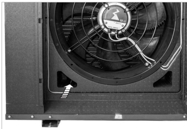
Afb. 32: Overzicht SolvisPia en positie van de kabeldoorvoer van de condensatafvoerverwarming (vooraanzicht)
