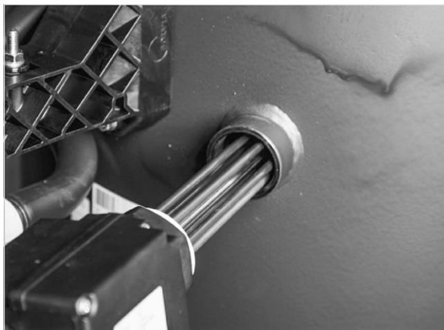
Abb. 4: Heizstab einsetzen
