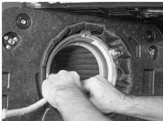
Fig. 56: Inserimento del cavo di tenuta del bruciatore, giunzione a ore 1
