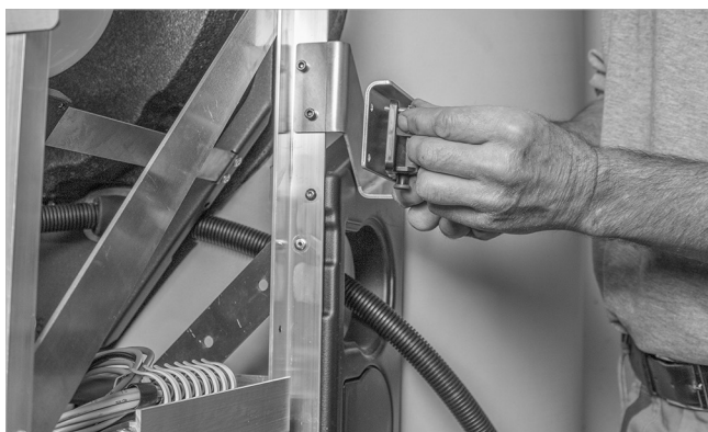
Fig. 64: Fissare la piastra di tenuta
