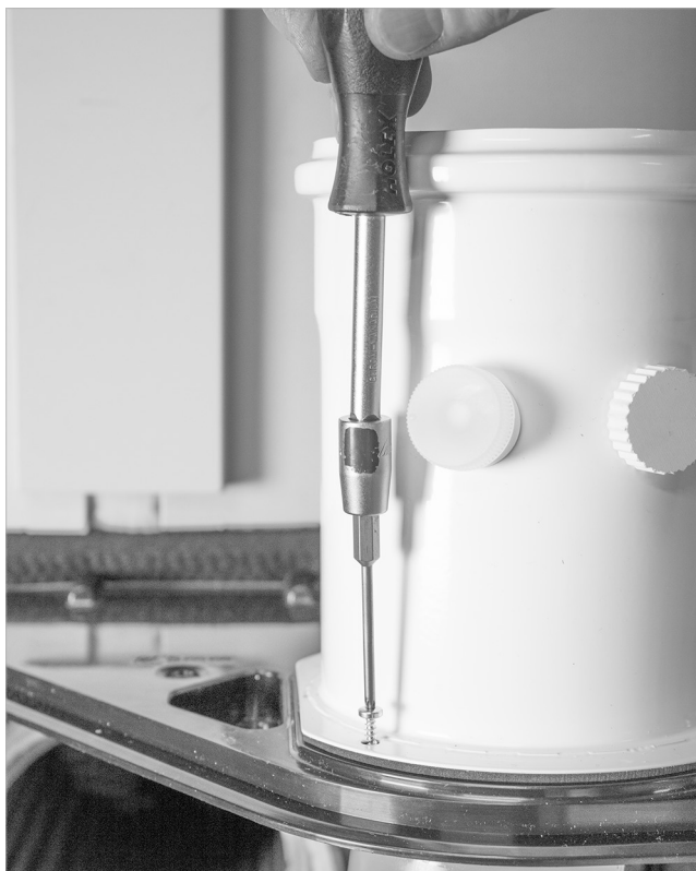
Fig. 37: Montaggio del raccordo scarico fumi
