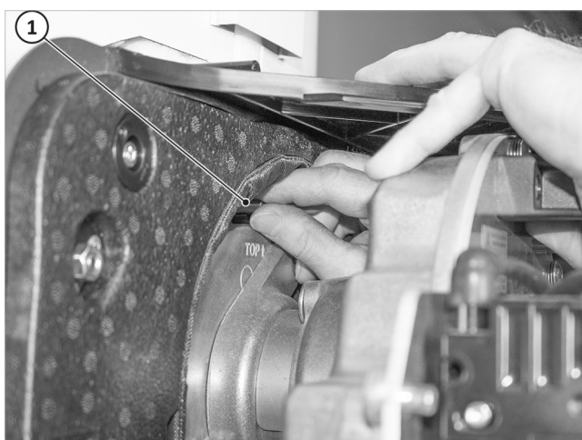
Fig. 61: Fissare il bruciatore con i dadi lunghi (1)
