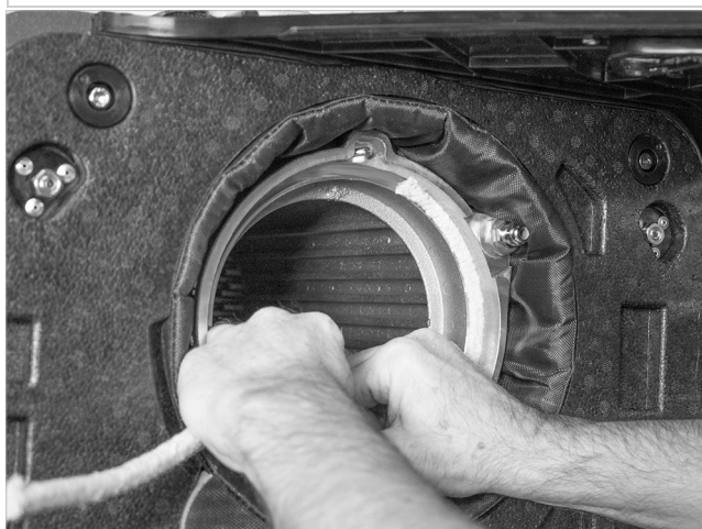
Fig. 38: Inserimento del cavo di tenuta del bruciatore, giunzione a ore 1
