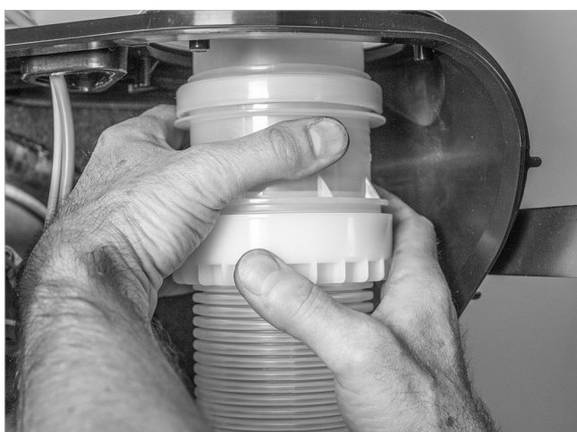
Fig. 82: Avvitare il tubo flessibile con l'accoppiamento del tubo di scarico
