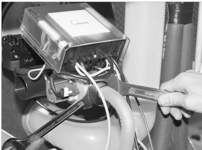
Fig. 45: Collegamento della condotta del gas
