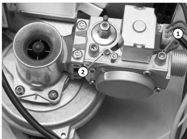
Fig. 124: Regolazione del bruciatore
