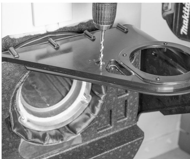
Fig. 52: Foro con diametro 5,2 mm
