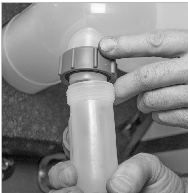
Fig. 86: Avvitare a mano il sifone per la condensa
