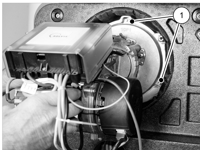
Fig. 42: Instalación del quemador
