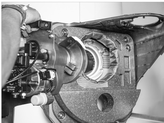
Fig. 60: Instalación del quemador
