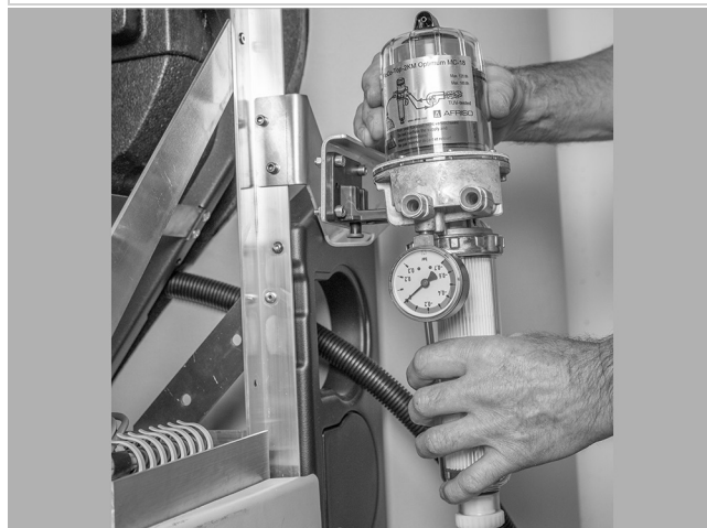
Fig. 65: Montaje del filtro de gasóleo
