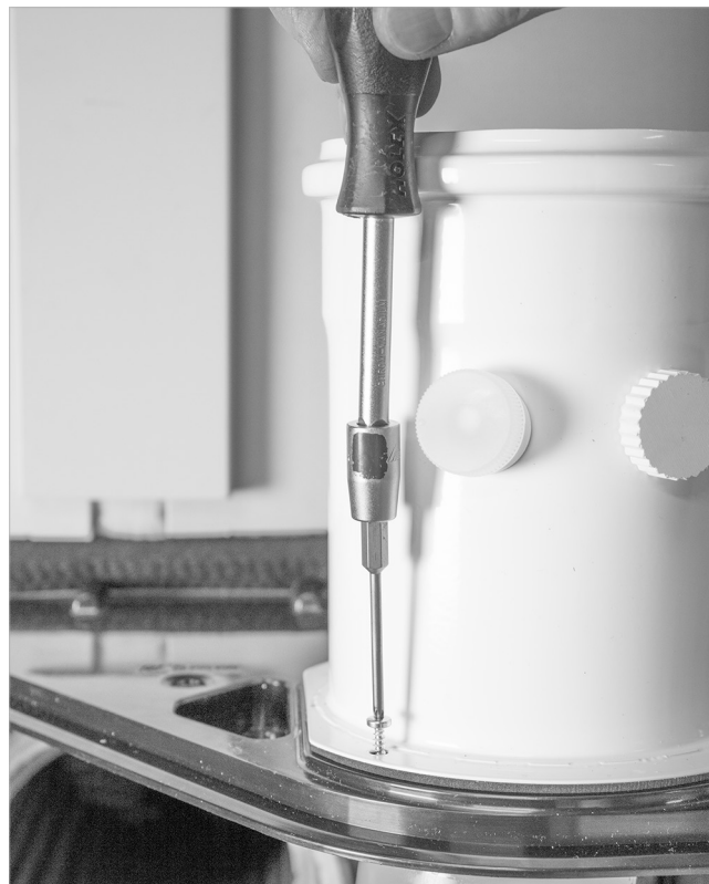
Fig. 37: Montar la pieza de conexión para la salida de humos
