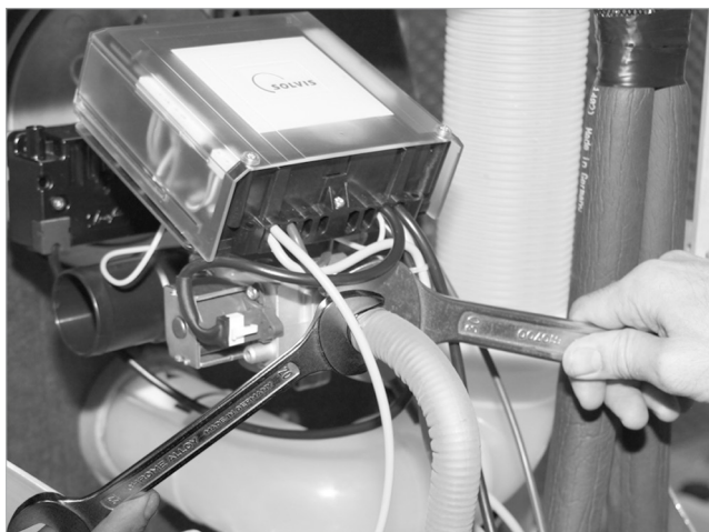
Fig. 45: Conectar la tubería de gas
