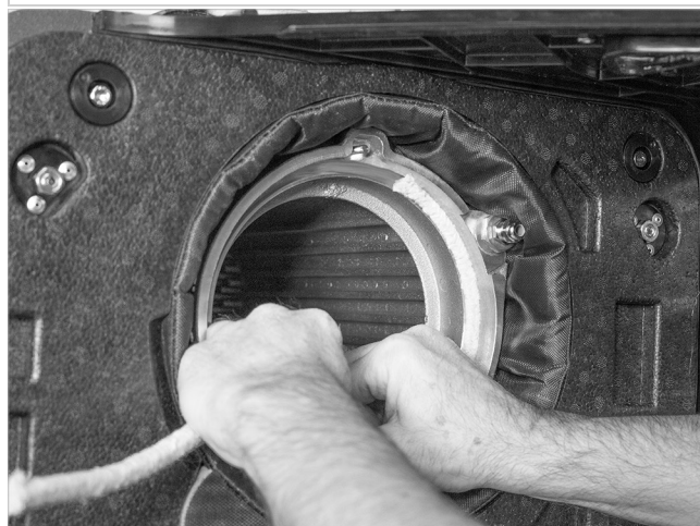
Fig. 56: Colocación del cordón de estanqueidad del quemador, junta a la 1 en punto
