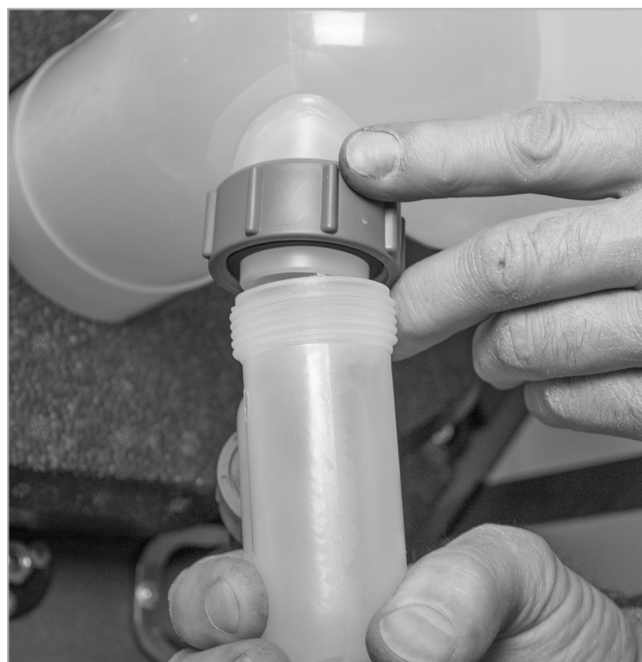
Fig. 86: Atornillar a mano el sifón de condensados
