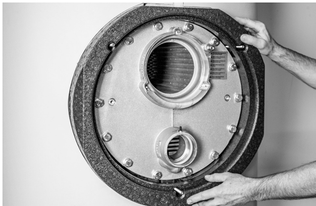
Fig. 8: Colocar el aislante trasero de la brida (anillo EPP)
