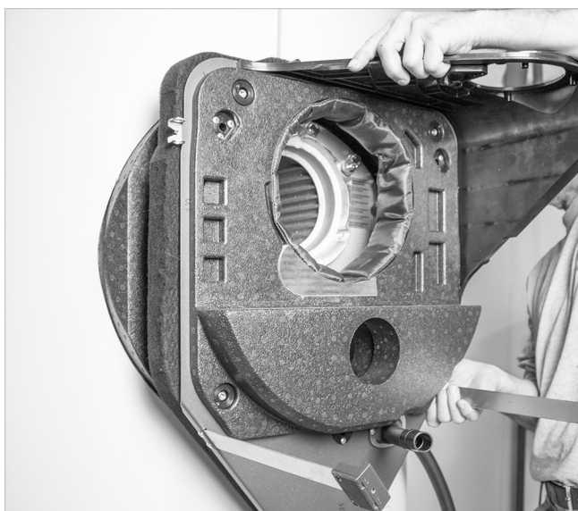
Fig. 13: Colocar la pared trasera de la cámara de aspiración
