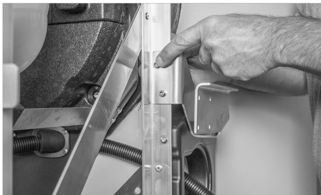
Fig. 63: Fijación del soporte del filtro de gasóleo
