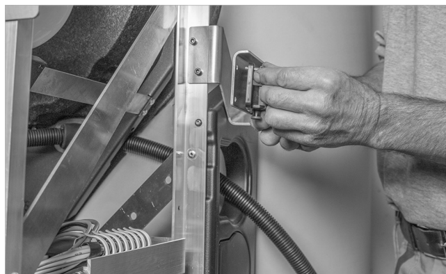
Fig. 64: Fijar la placa de soporte
