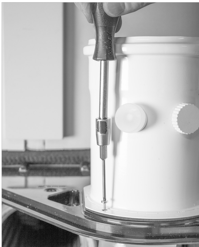
Fig. 53: Montar la pieza de conexión para la salida de humos
