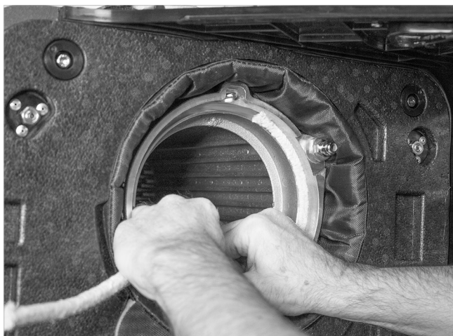
Fig. 38: Colocación del cordón de estanqueidad del quemador, junta a la 1 en punto
