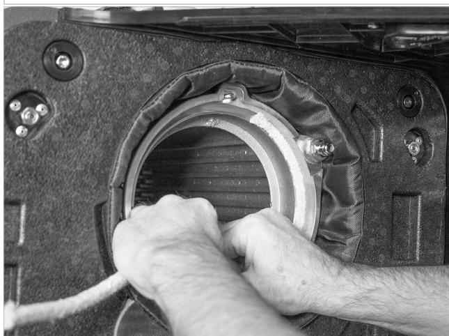
Afb. 56: Branderafsluitkoord plaatsen, naad op 1 uur
