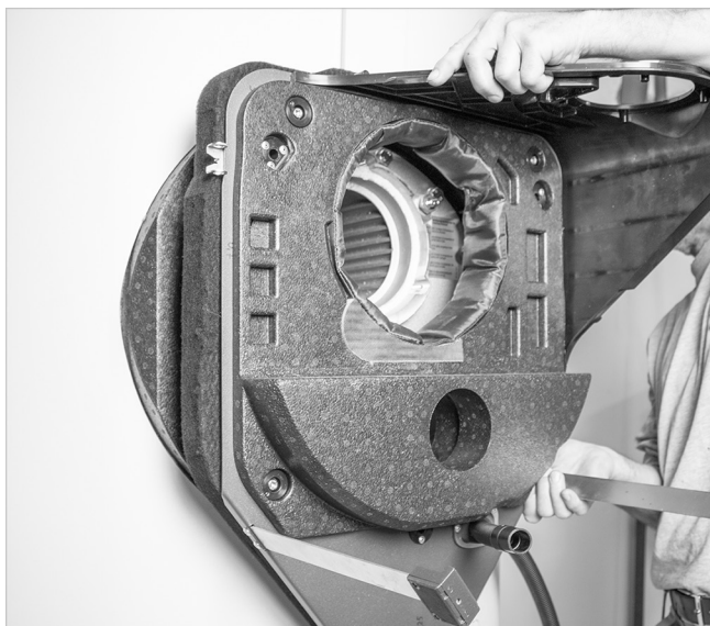
Afb. 13: Achterwand aanzuigkamer plaatsen
