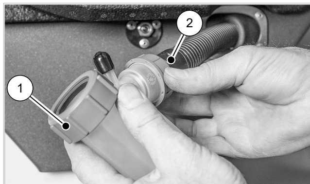
Afb. 84: Condensaatsifon aansluiten op de condensslang
