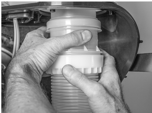
Afb. 82: Flexibele buis aan koppeling rookgasbuis vastschroeven
