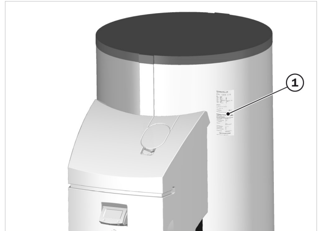
Afb.133: Kopie typeplaatje (1) op isolatie geplakt
