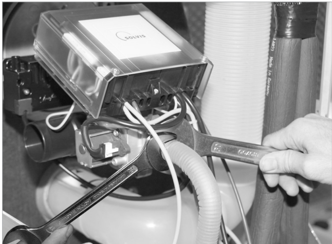
Afb. 45: Gasleiding aansluiten
