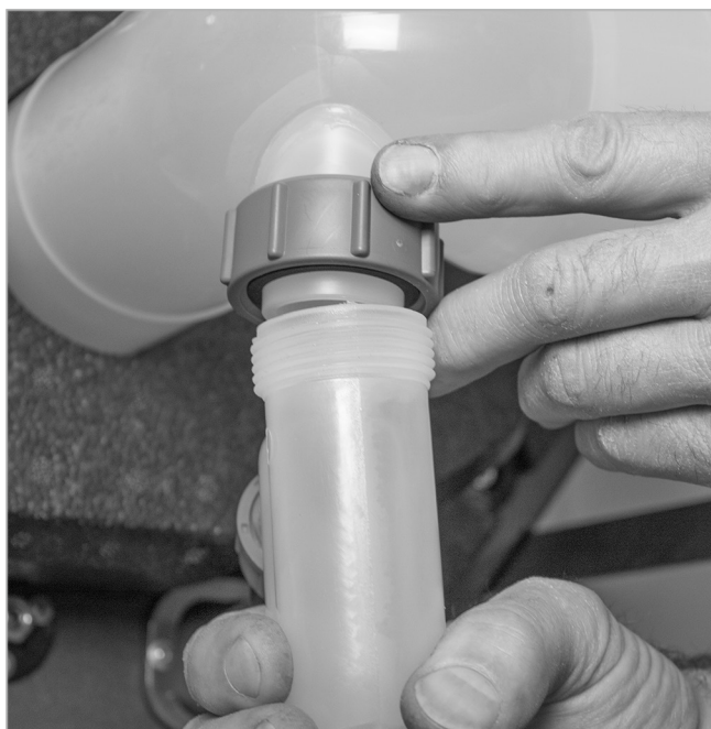
Afb. 86: Condensaatsifon handvast vastschroeven
