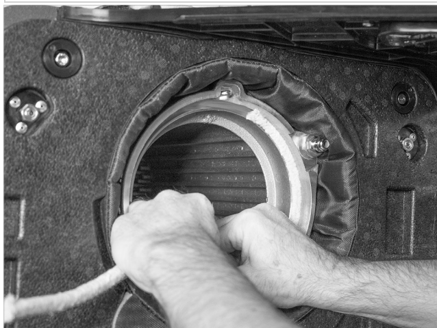
Afb. 38: Branderafsluitkoord plaatsen, naad op 1 uur
