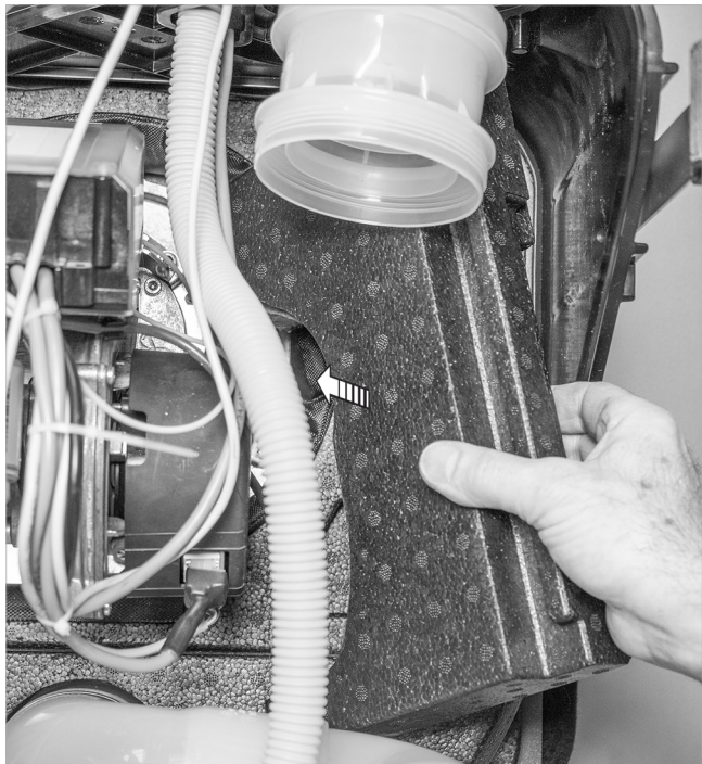
Afb. 92: Montage van de rechter voorste flensisolatie (deel II)
