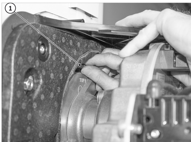
Afb. 61: Brander met lange moeren (1) vastzetten
