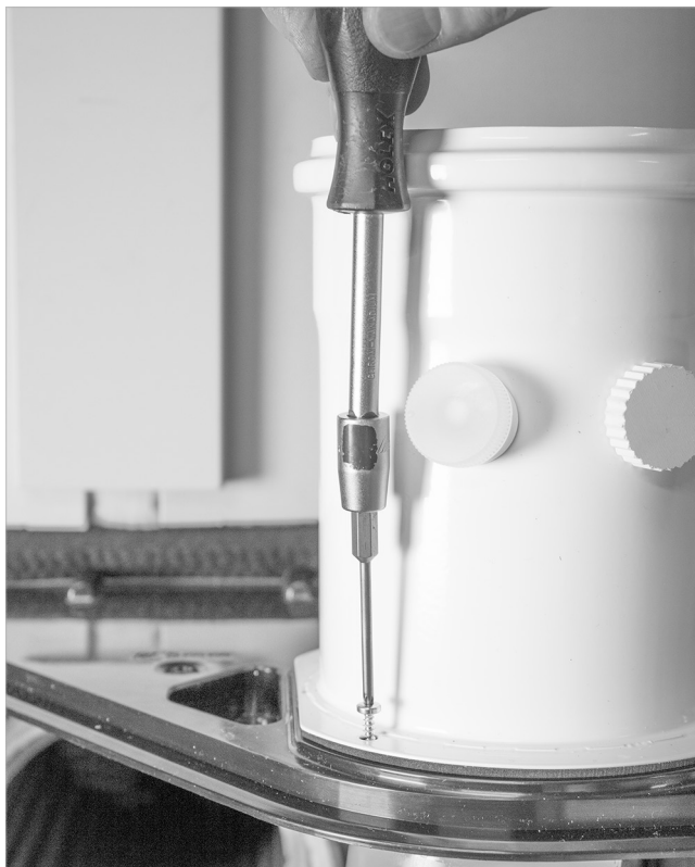
Afb. 53: Rookgasaansluitstuk monteren
