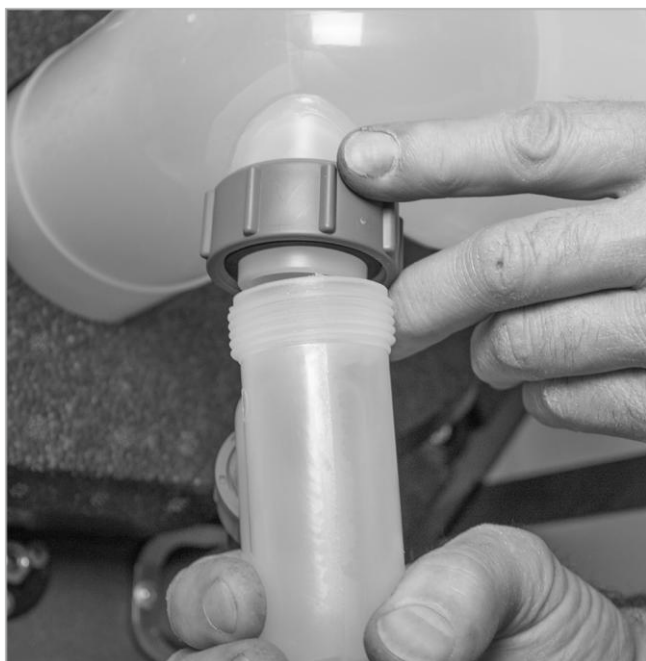
Fig. 88: Avvitare a mano il sifone per la condensa
