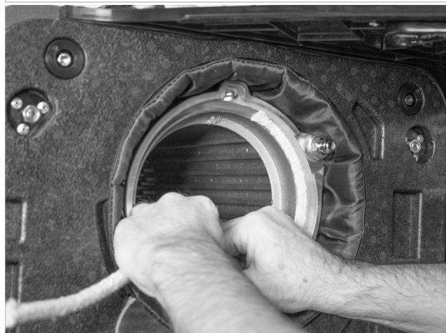
Fig. 48: Inserimento del cavo di tenuta del bruciatore, giunzione a ore 1
