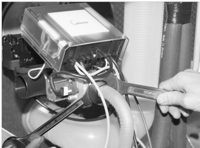
Fig. 55: Collegamento della condotta del gas
