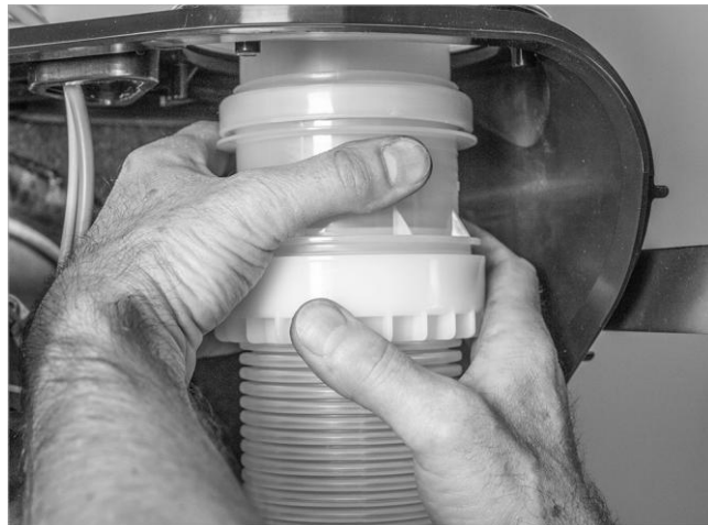
Fig. 85: Avvitare il tubo flessibile con l'accoppiamento del tubo di scarico
