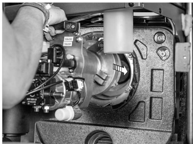
Fig. 65: montaggio del bruciatore
