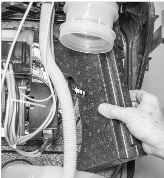
Fig. 98: Installazione dell'isolamento della flangia anteriore destra (parte II)
