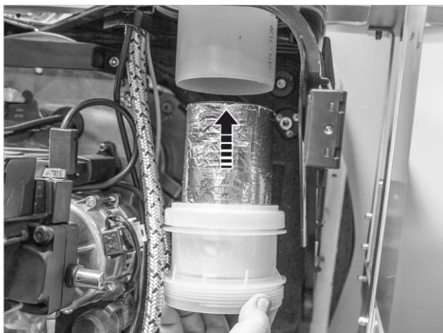
Fig. 81: Inserire il silenziatore corto sopra
