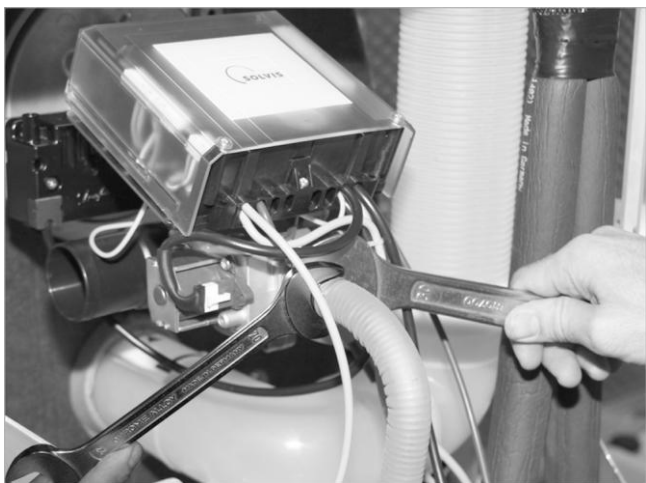
Fig. 55: Conectar la tubería de gas
