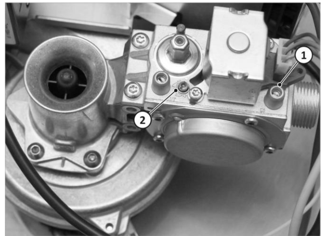
Fig. 119: Ajuste del quemador
