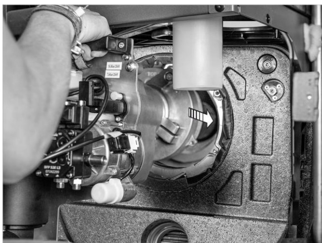
Fig. 65: Instalación del quemador
