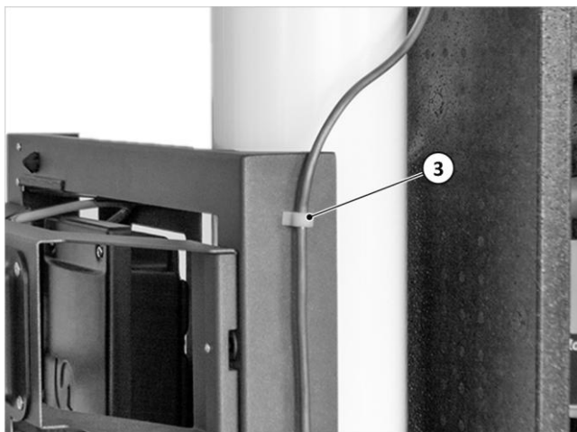
Fig. 74: Fije la tubería de alimentación de gasóleo en el bastidor
