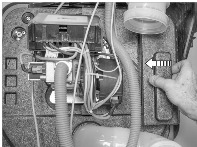
Fig. 99: Montaje del aislamiento de la brida delantera derecha (parte III)
