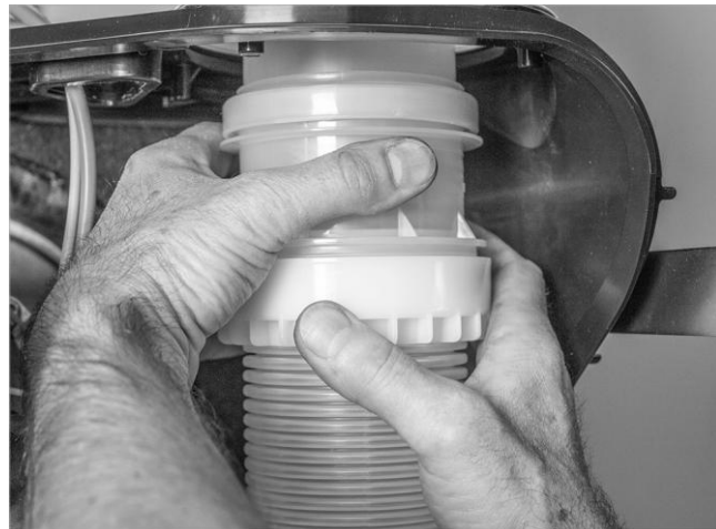
Fig. 85: Atornillar el tubo flexible con el acoplamiento del tubo de salida de humos
