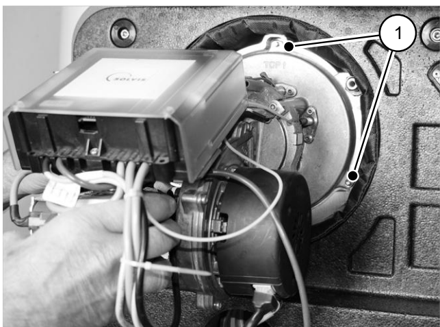
Fig. 52: Instalación del quemador
