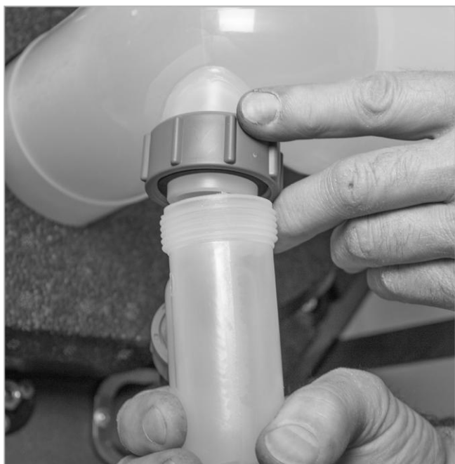
Fig. 88: Atornillar a mano el sifón de condensados
