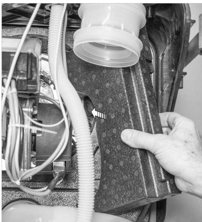
Fig. 98: Montaje del aislamiento delantero derecho de la brida (parte II)
