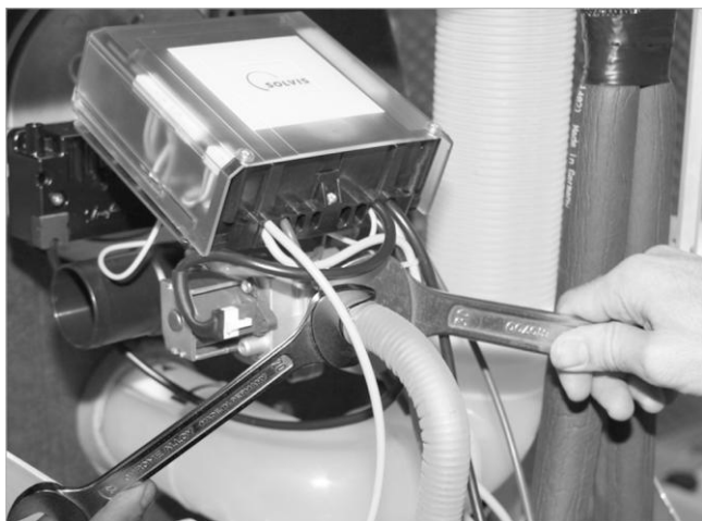
Afb. 55: Gasleiding aansluiten
