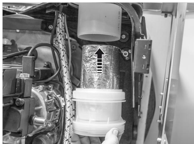
Afb. 81: Korte geluiddemper aan de bovenkant erin zetten
