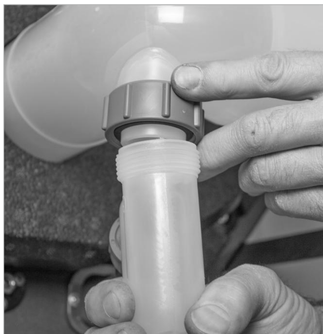
Afb. 88: Condensaatsifon handvast vastschroeven
