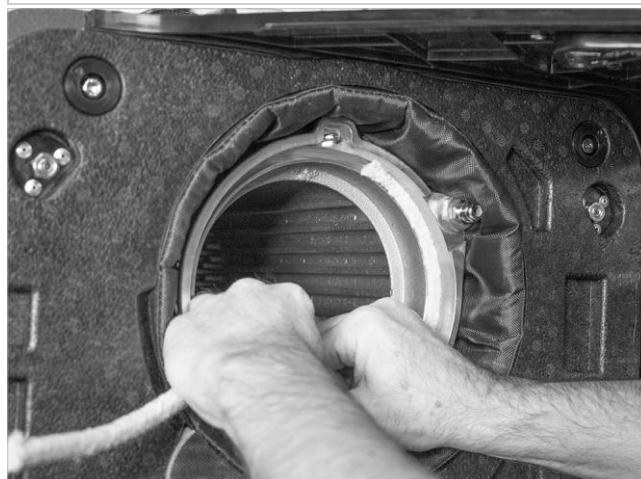
Afb. 48: Branderafsluitkoord plaatsen, naad op 1 uur
