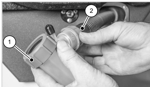
Afb. 86: Condensaatsifon aansluiten op de condensslang
