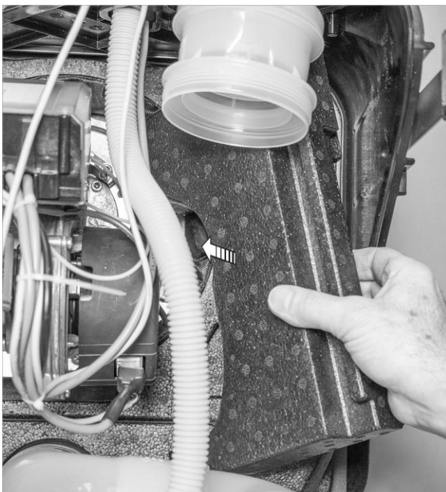
Afb. 98: Montage van de rechter voorste flensisolatie (deel II)
