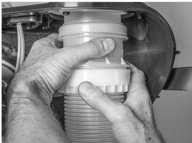
Afb. 85: Flexibele buis aan koppeling rookgasbuis vastschroeven
