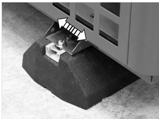
Abb. 1: Position von Wärmepumpe/Schwingungsdämpfer abstimmen
