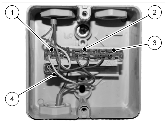
Abb. 17: Verdrahtung der Modbus Anschlussbox in SolvisBruno
