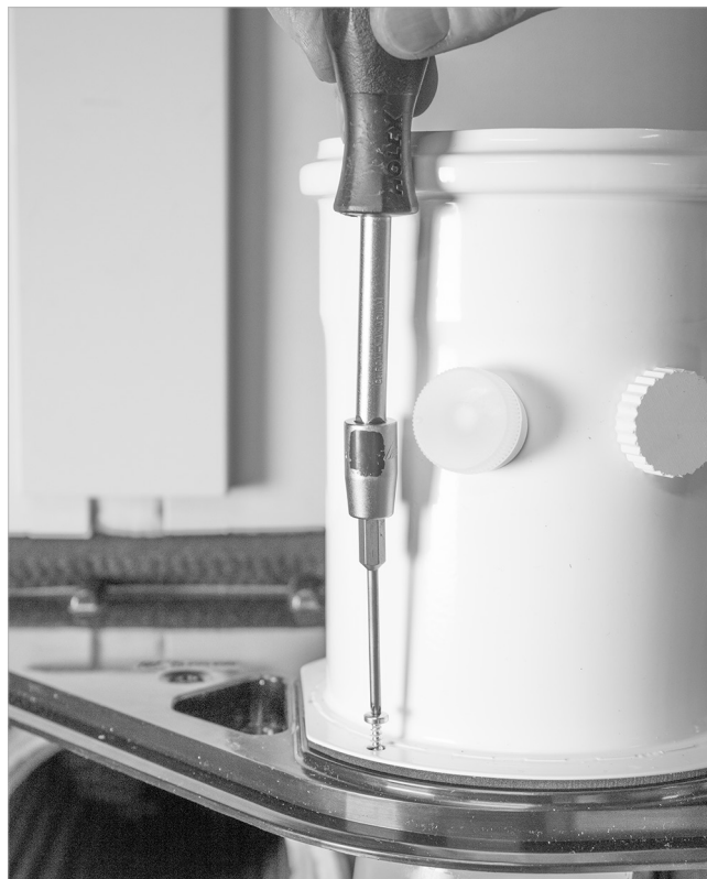
Abb.53: Abgasanschlusstück montieren
