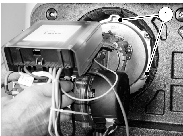
Abb. 42: Brenner einbauen
