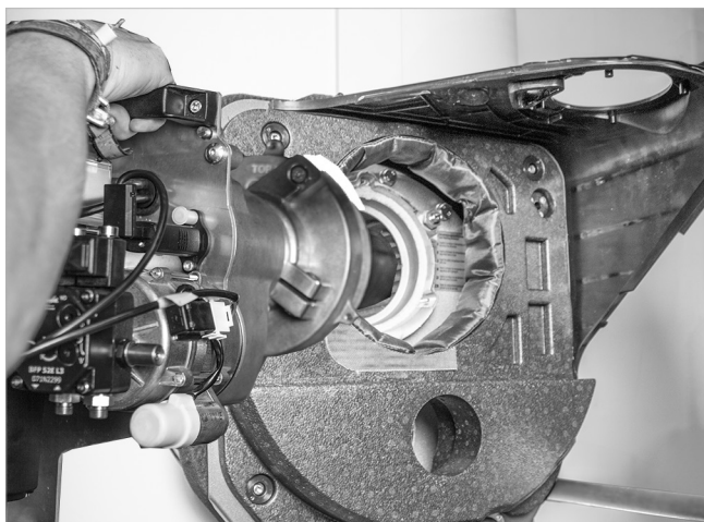
Abb. 60: Brenner einbauen
