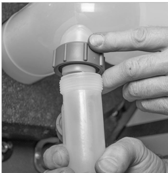
Abb. 86: Kondensatsiphon handfest anschrauben
