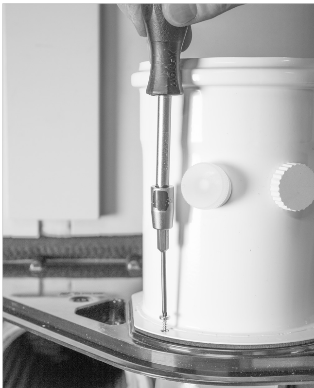
Abb.37: Abgasanschlusstück montieren
