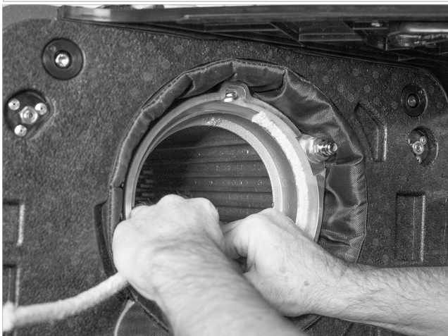
Abb. 38: Brennerdichtschnur einlegen, Stoß bei 1 Uhr
