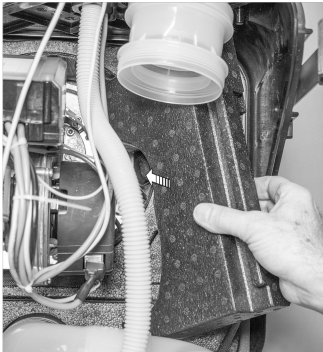
Abb. 92: Einbau der rechten vorderen Flanschisolierung (Teil II)
