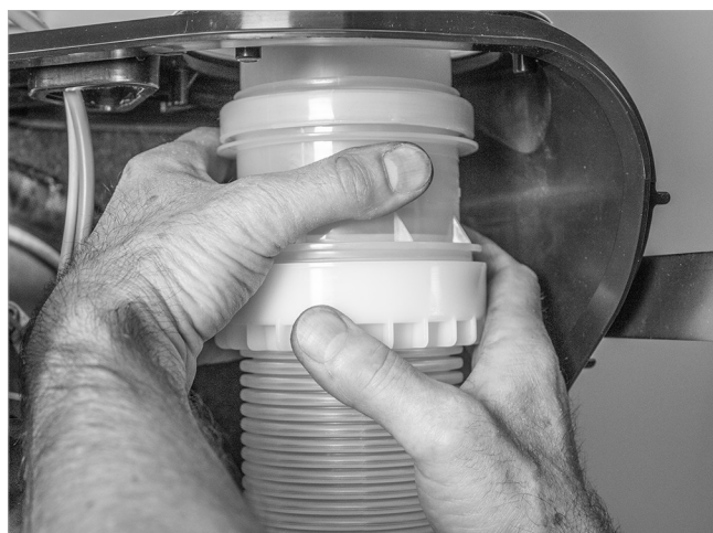
Abb. 82: Flexrohr mit Kupplung Abgasrohr verschrauben
