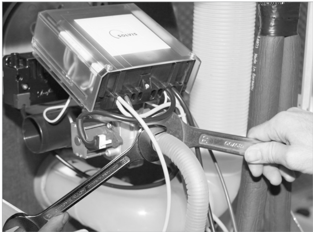
Abb. 45: Gasleitung anschließen
