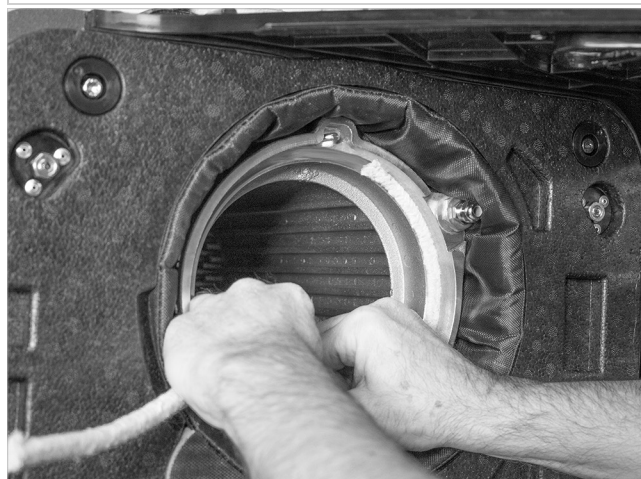
Abb. 48: Brennerdichtschnur einlegen, Stoß bei 1 Uhr
