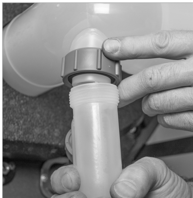
Abb. 88: Kondensatsiphon handfest anschrauben
