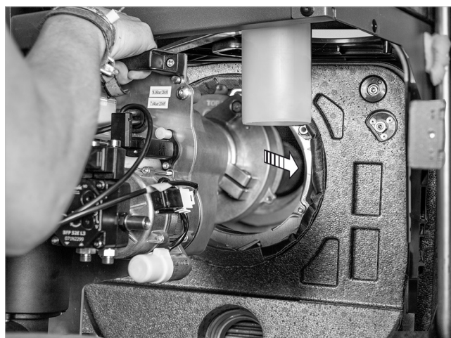
Abb. 65: Brenner einbauen
