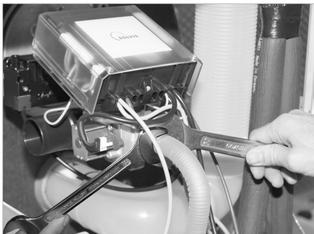
Abb. 55: Gasleitung anschließen
