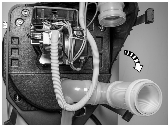
Abb. 97: Abgasrohr herunterklappen
