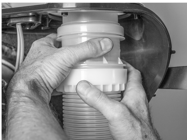
Abb. 85: Flexrohr mit Kupplung Abgasrohr verschrauben
