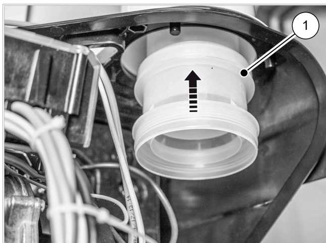
Abb. 79: Kupplung Abgasrohr auf Abgasanschlussstück stecken.
