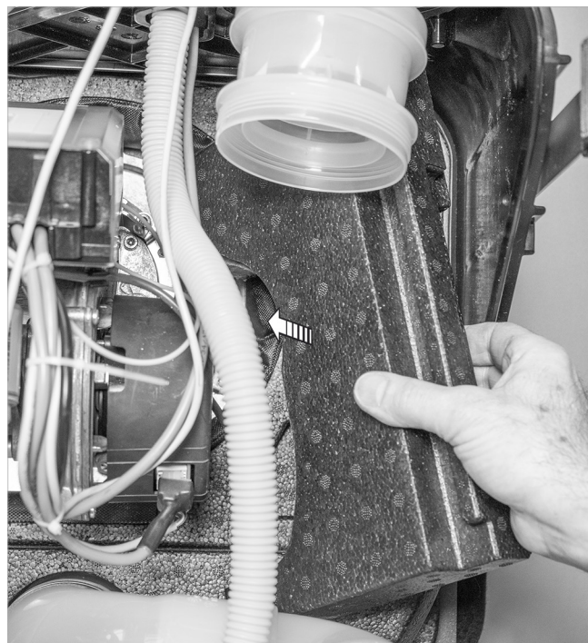
Abb. 98: Einbau der rechten vorderen Flanschisolierung (Teil II)
