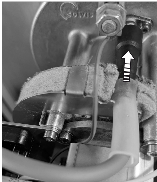
Abb. 1: Neues Zündkabel, montiert
