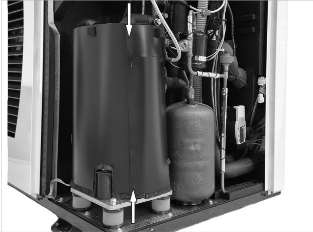
Abb. 1: Dämmmatte nach Lösen der Klettbinder (Pfeil) entnehmen
