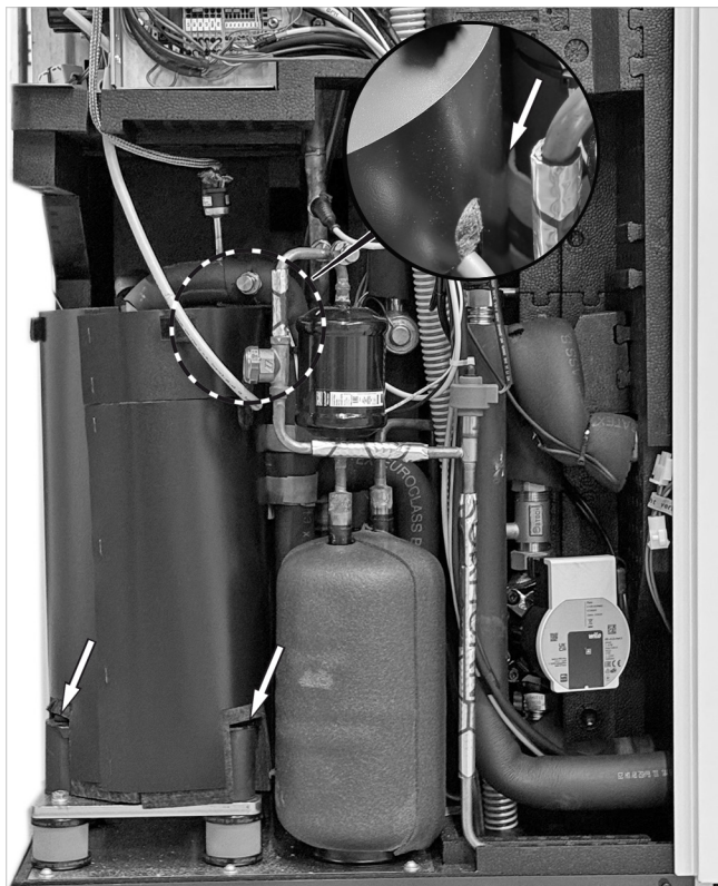
Abb. 7: Dämmmatte montiert (Ansicht von der Seite)
