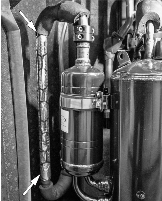
Abb. 5: Alubutylband an der Sauggasleitung montiert (Ansicht von der Ausblasseite)
