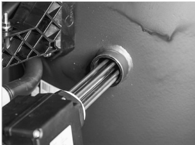
Abb. 2: Heizstab einsetzen
