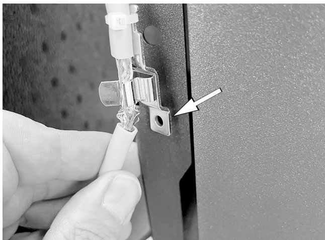
Fig. 6: Fijación de la abrazadera de apantallamiento a la puerta de la placa de circuitos de red SolvisBen
