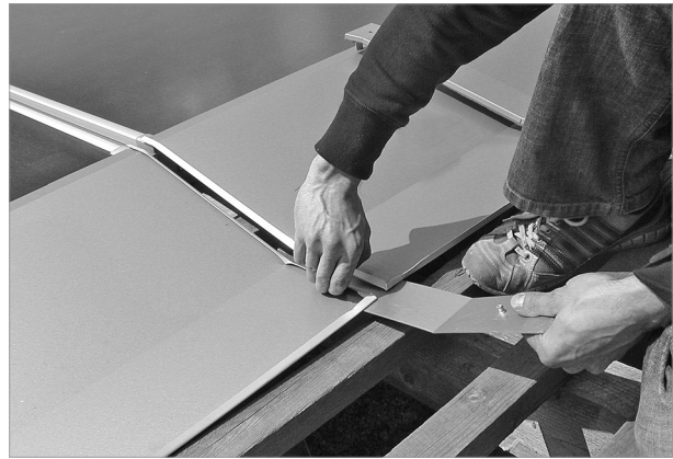
Abb. 81: Das untere Blech des Verbinders unter die Oberbleche schieben
