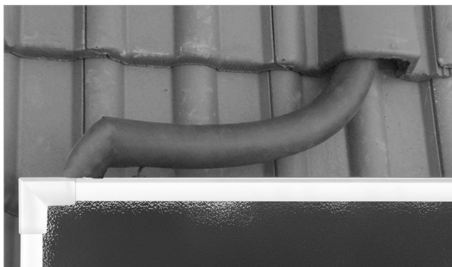
Abb. 93: Rücklauf anschließen
