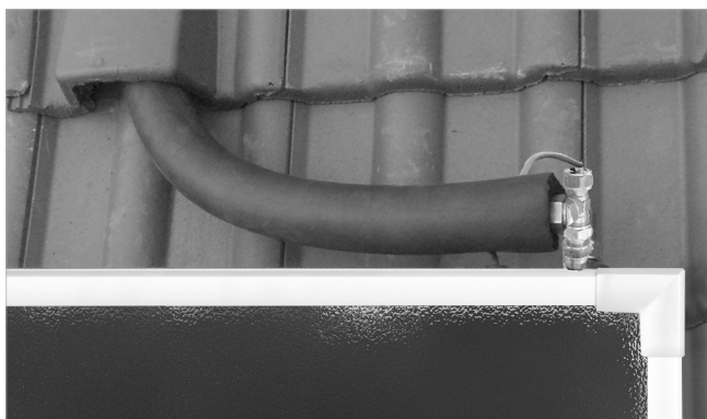
Abb. 94: Vorlauf anschließen
