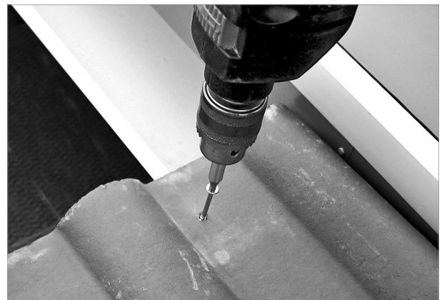
Abb. 88: Ziegel neben dem Seitenblech befestigen
