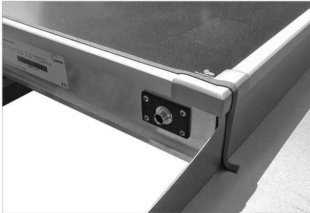
Abb. 79: Fugendichtband am oberen Rand über die ganze Breite aufkleben
