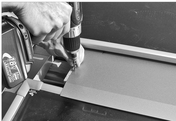
Abb. 72: Zwischenblech etwa 10 mm von linker Außenkante anschrauben
