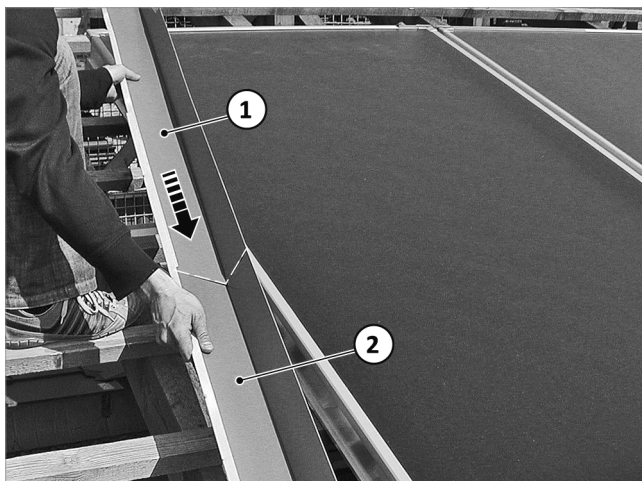
Abb. 63: Oberes Seitenblech über das untere schieben
