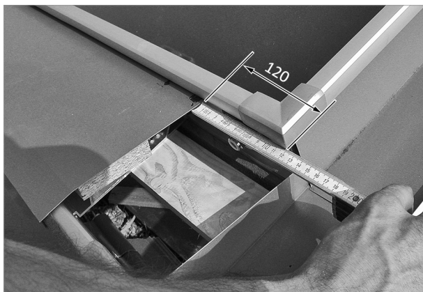
Abb. 71: Blech auf Abstand zur Außenkante bringen
