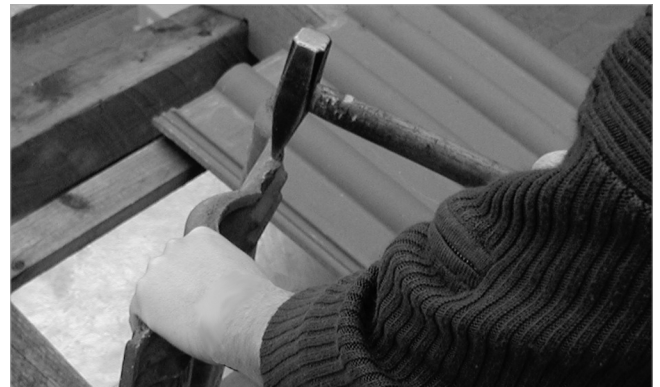
Abb. 87: Ggf. Haltenasen entfernen
