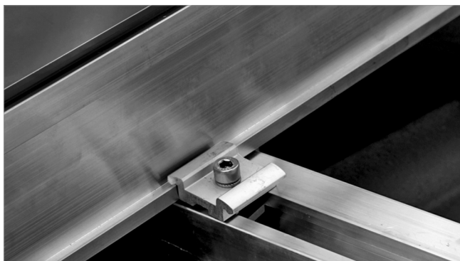
Fig. 18: Pinza intermedia colocada pero sin apretar
