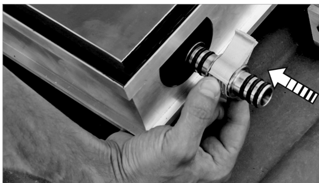
Afb. 19: Collectorverbindingsstuk insteken
