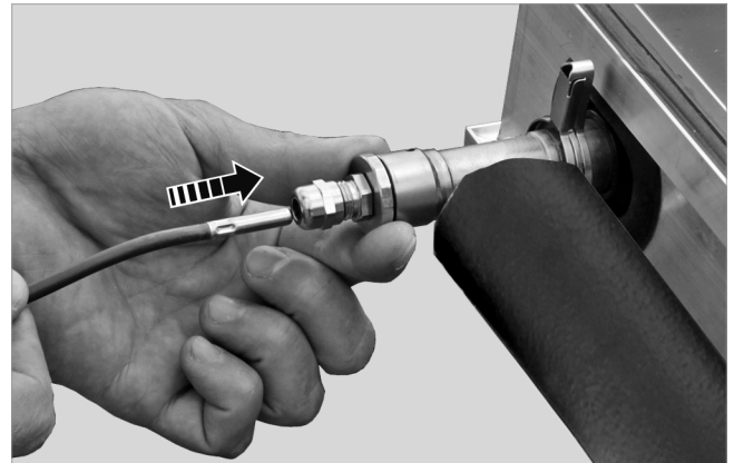
Fig. 50: Montage van de sensor
