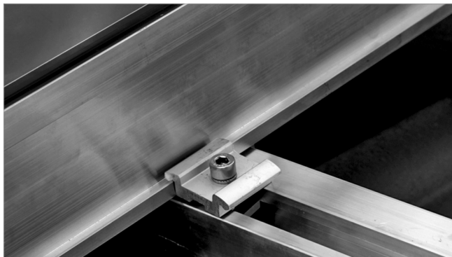
Afb. 41: Centreekklemmen eerst losjes gemonteerd
